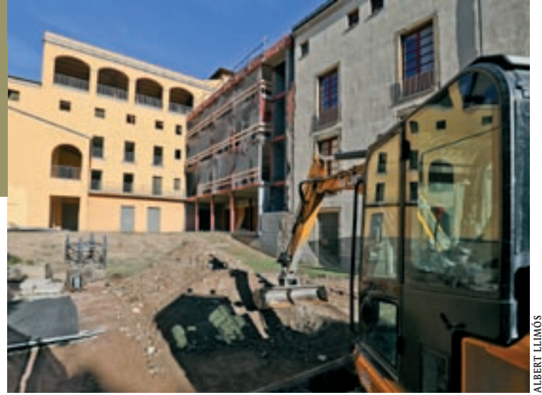
Vista actual de les primeres excavacions al parc Maria Àngels Anglada
