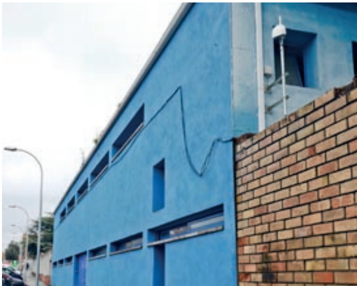
El nou aparell que s'ha col·locat a fora les piscines
