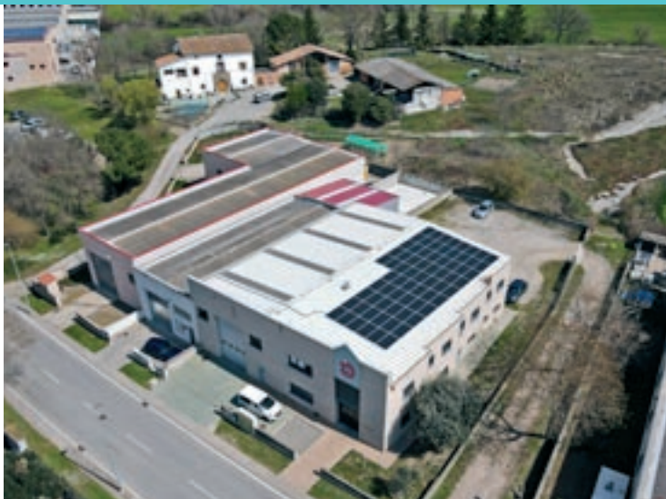
La coberta amb panells fotovoltaics de CMTEC de Torelló
