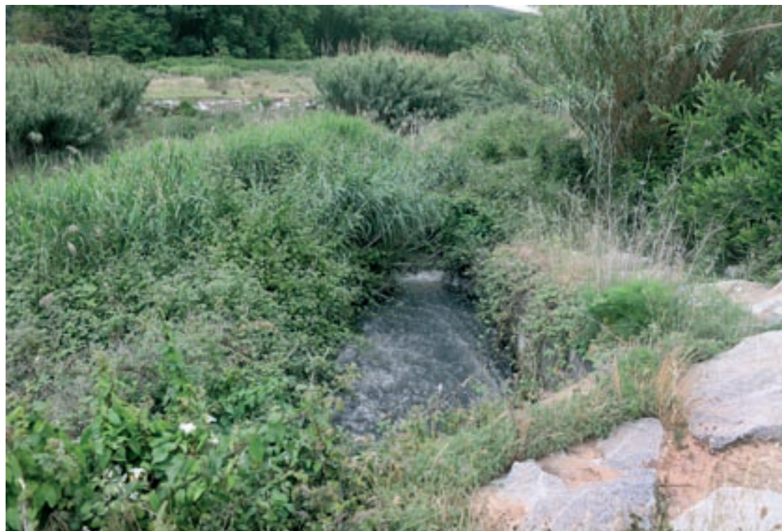
El canal de sortida de l'aigua de la depuradora de la Llagosta al Besòs en una imatge del maig de 2021
