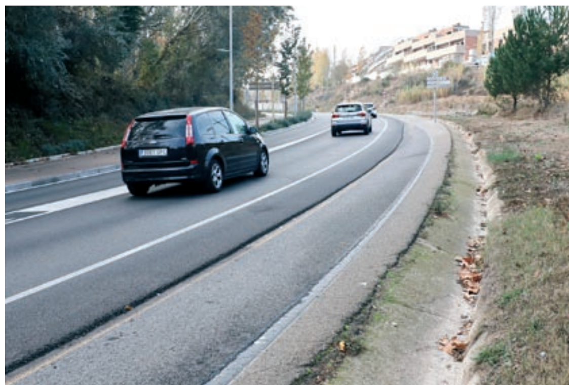
El tram de poc més de 400 metres del costat nord de la carretera de Granollers a Lliçà d'Amunt on es farà la vorera
