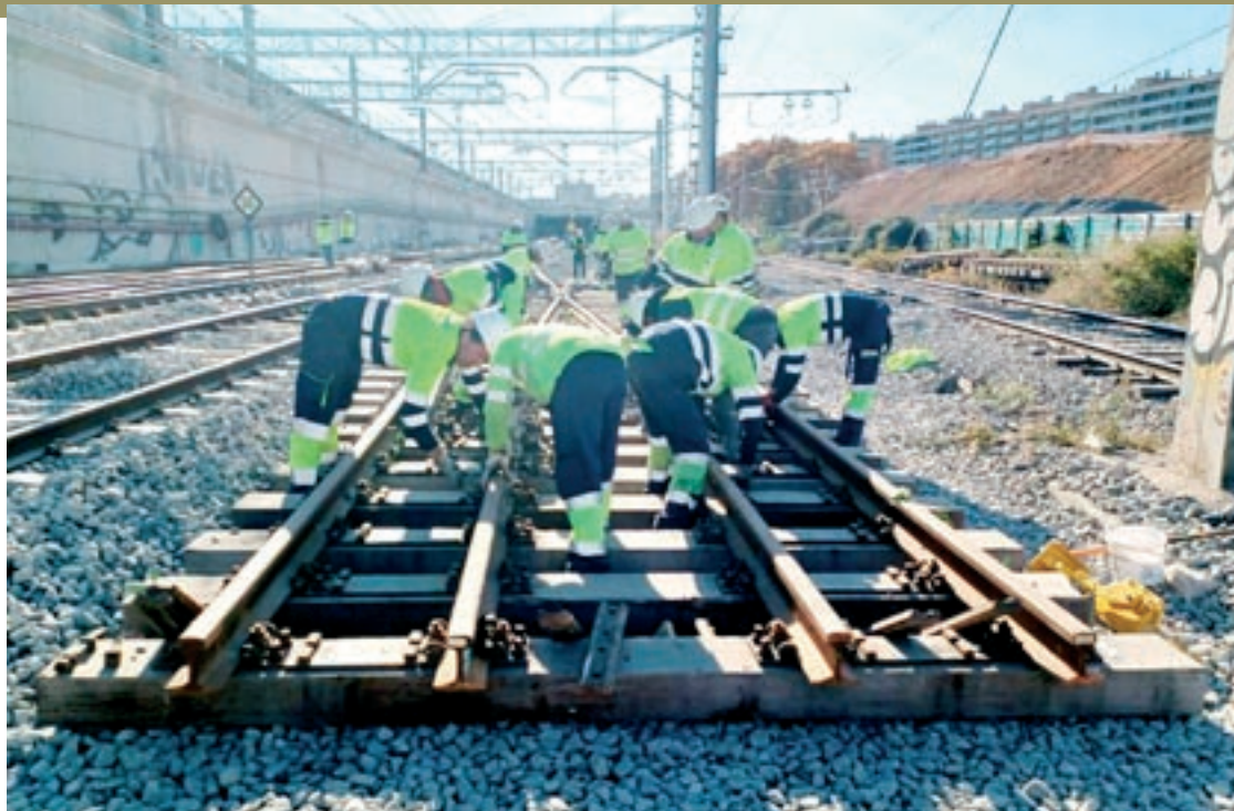
Operaris d'Adif treballant en la connexió de les vies de la línia de França amb el nou traçat al nus de la Trinitat
