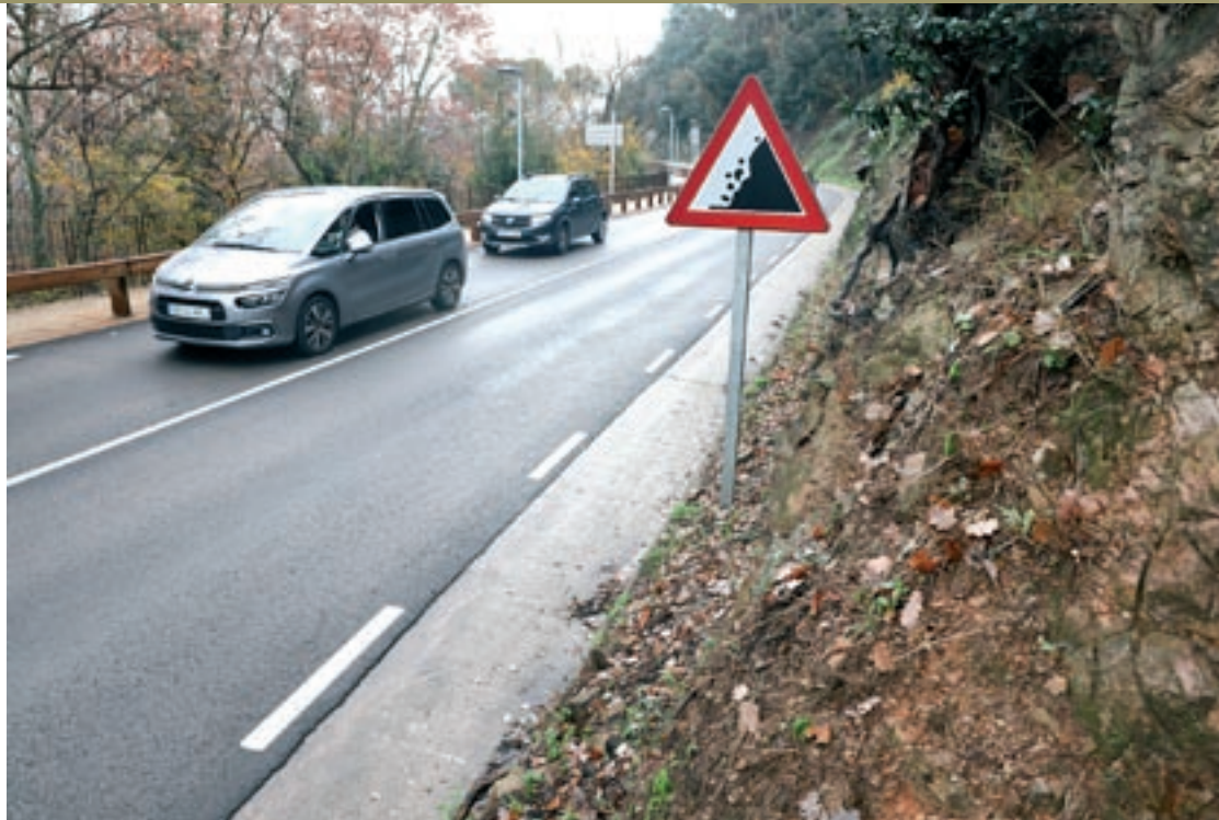
La Diputació té en licitació uns treballs de protecció de talussos en aquest tram entre Martorelles i Montornès
