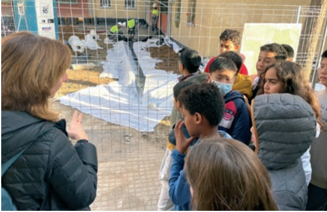
Els alumnes van poder veure de prop els treballs d'impermeabilització dels sòcols de les façanes dels blocs de la plaça
