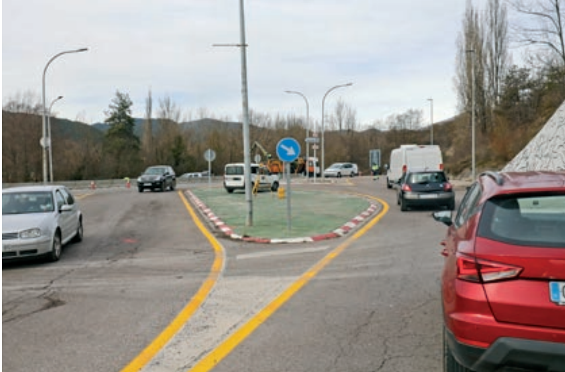
Obres al punt on s'ha de construir la rotonda, aquest dimecres al migdia
