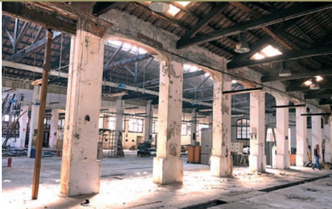
L'interior de l'antiga fàbrica metal·lúrgica, que es va construir entre els anys 1918 i 1919
