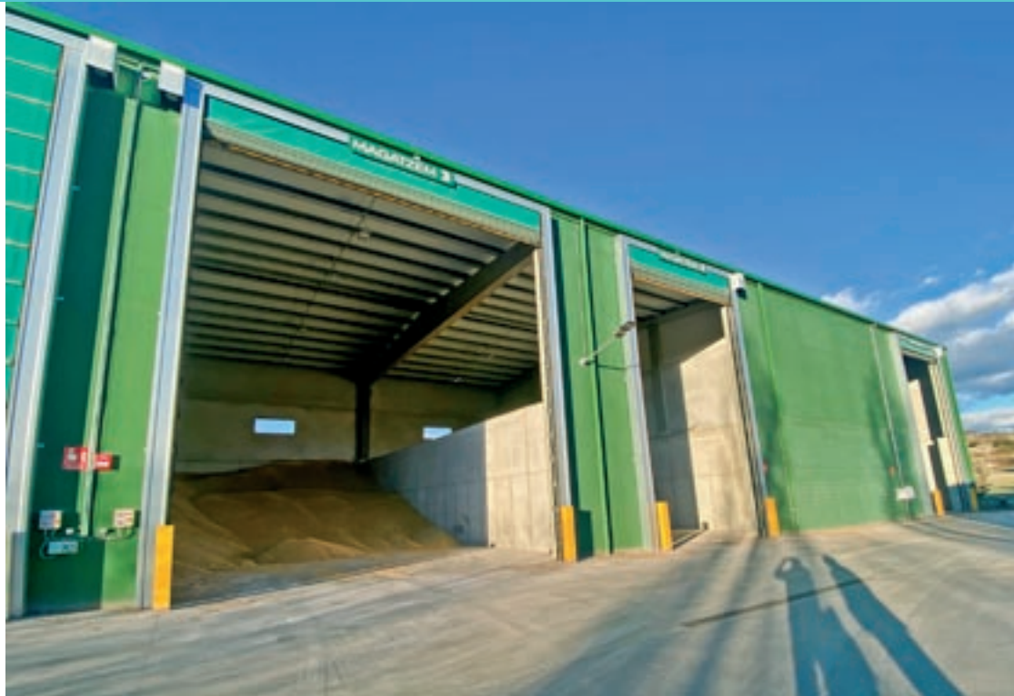
Reserves d'ordi a les instal·lacions de la fàbrica de pinso de la Cooperativa Plana de Vic
