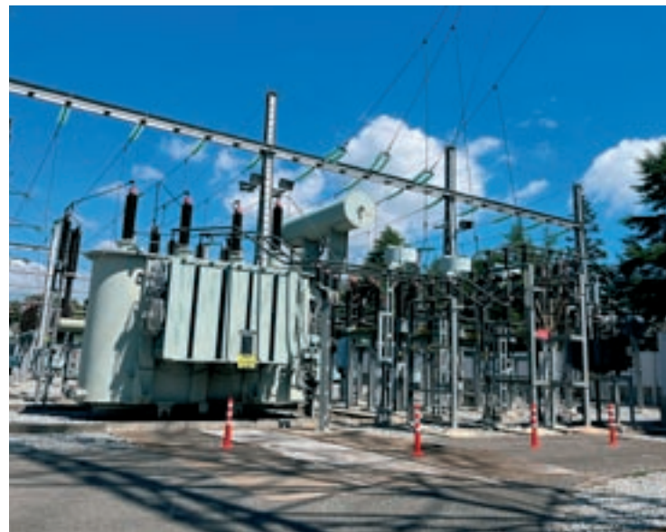
La nova instal·lació de la subestació té major capacitat i potència
