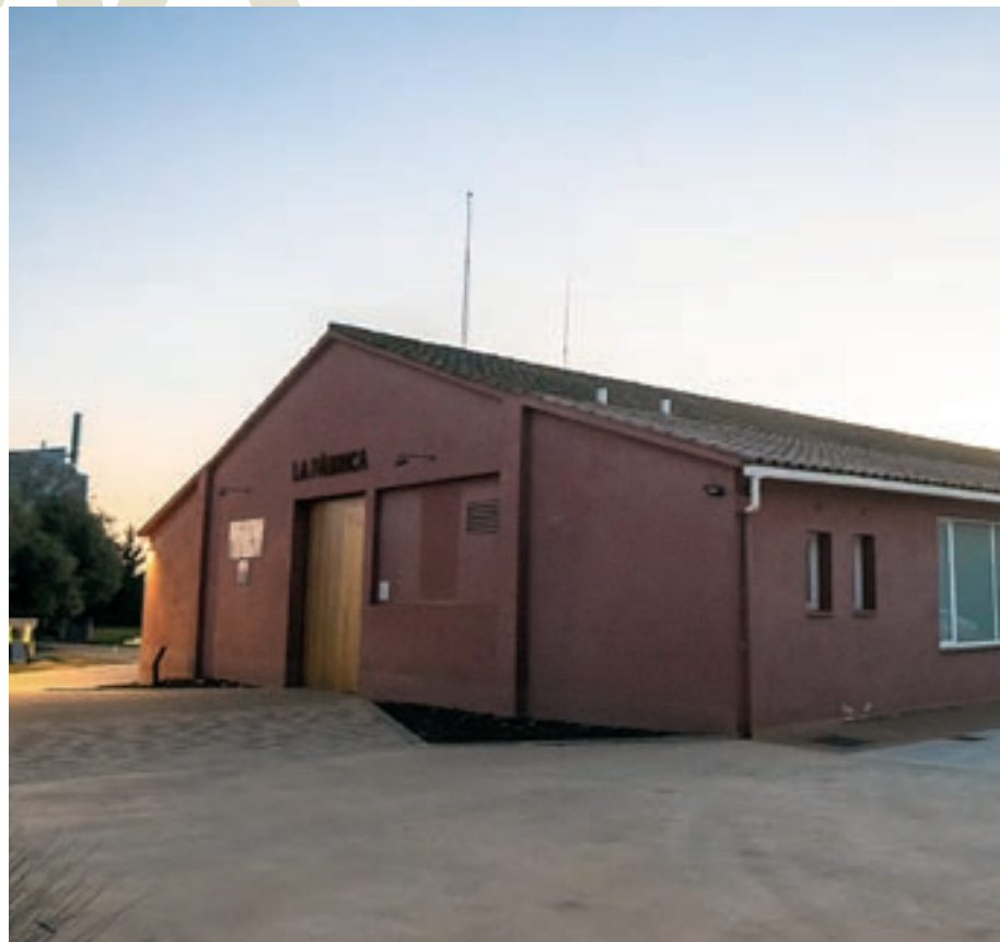
Sant Pere havia previst la instal·lació de plaques fotovoltaïques en equipaments com La Fàbrica
