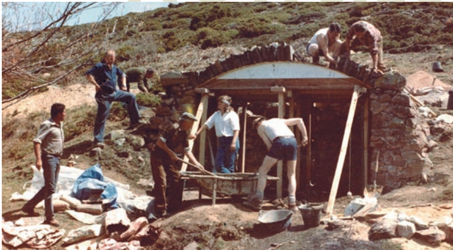
Treballs en la construcció de la coberta de la font de Matagalls
