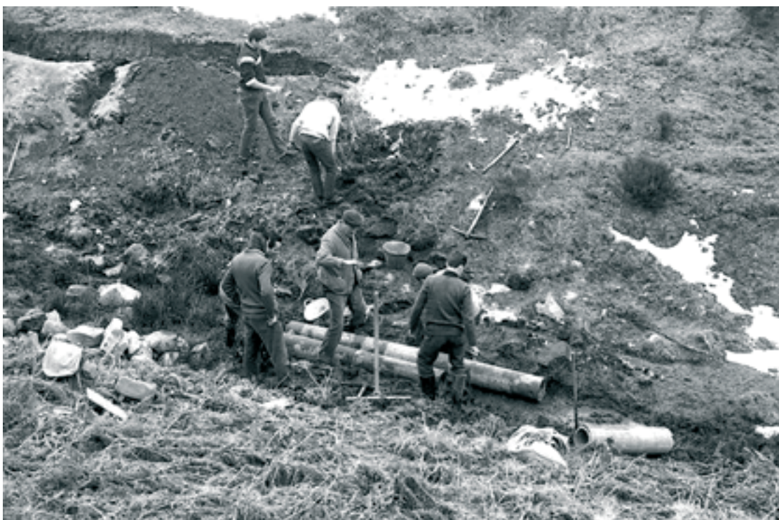
Preparatius per a la canalització de l'aigua de la font dels Garriguencs
