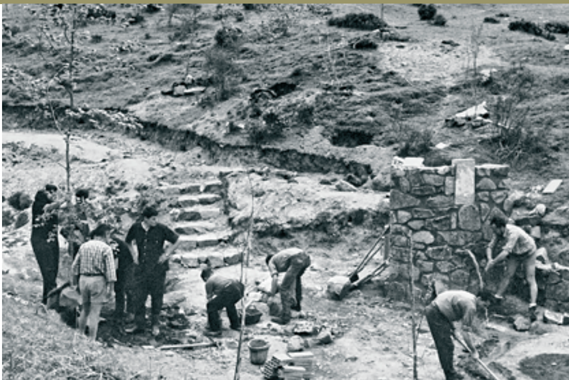
El procés de construcció de la Font del Garriguencs
