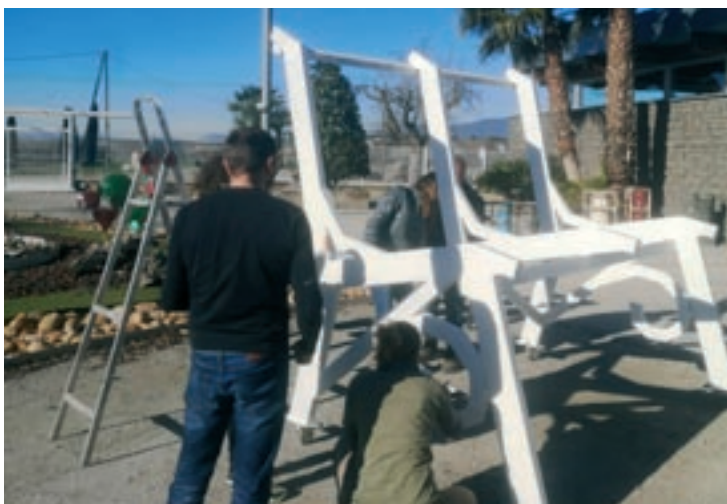
El banc gegant s'ha començat a instal·lar a 30 Passes
