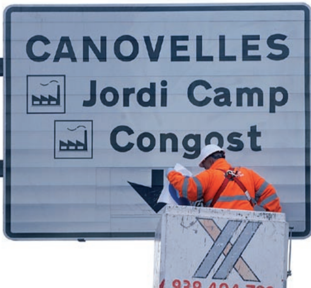
Uns operaris modificaven aquest dijous al matí el pòrtic de la N-152z d'entrada a Granollers per recollir-hi la prohibició d'accés dels camions al tram urbà
