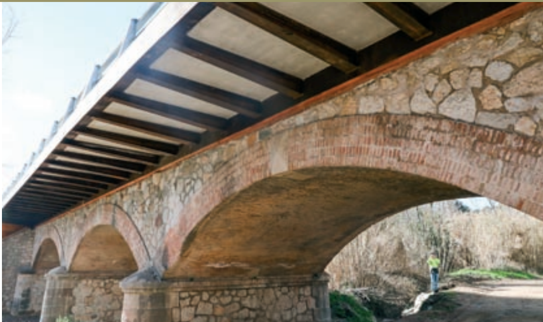
Detalls del voladís que s'ha fet als dos costats del pont i que ha permès eixamplar la calçada i crear la via de vianants
