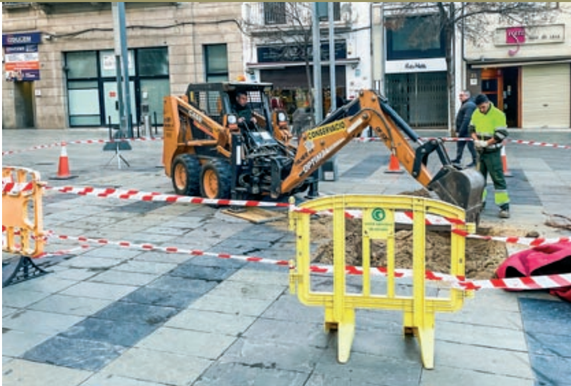
Operaris treballaven en la retirada de la soca de la morera tallada a la plaça Maluquer i Salvador, dimarts
