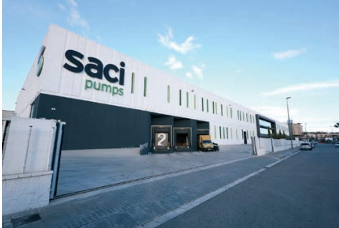
Saci va estrenar les instal·lacions de 8.000 metres quadrats a Granollers l'any 2019
