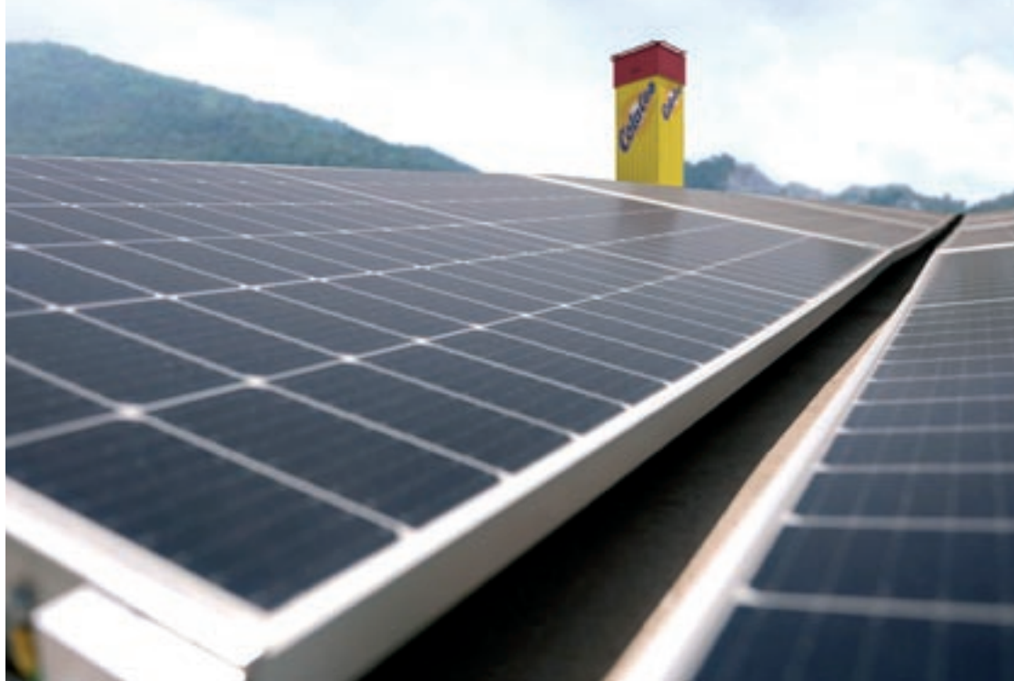
La instal·lació de plaques solars al centre productiu de Parets que Idilia va fer el 2021 es doblarà aquest any
