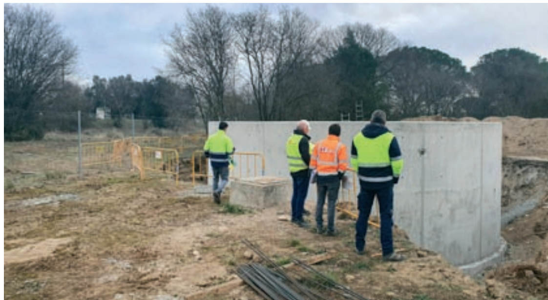
El nou dipòsit d'aigua potable, encara en construcció, està situat a la zona dels pous de la Batllòria
