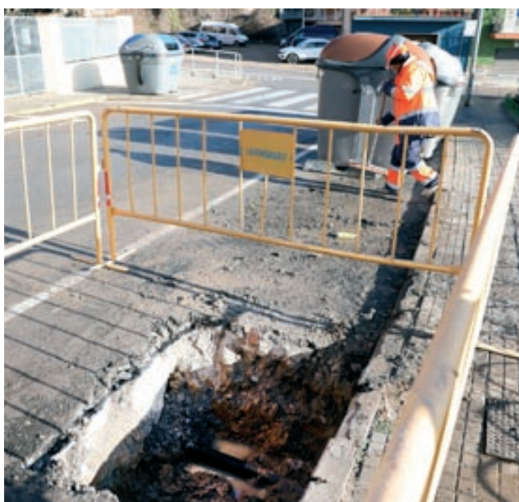
Operaris treballant per reparar la fuga d'aigua d'aquest dimecres
