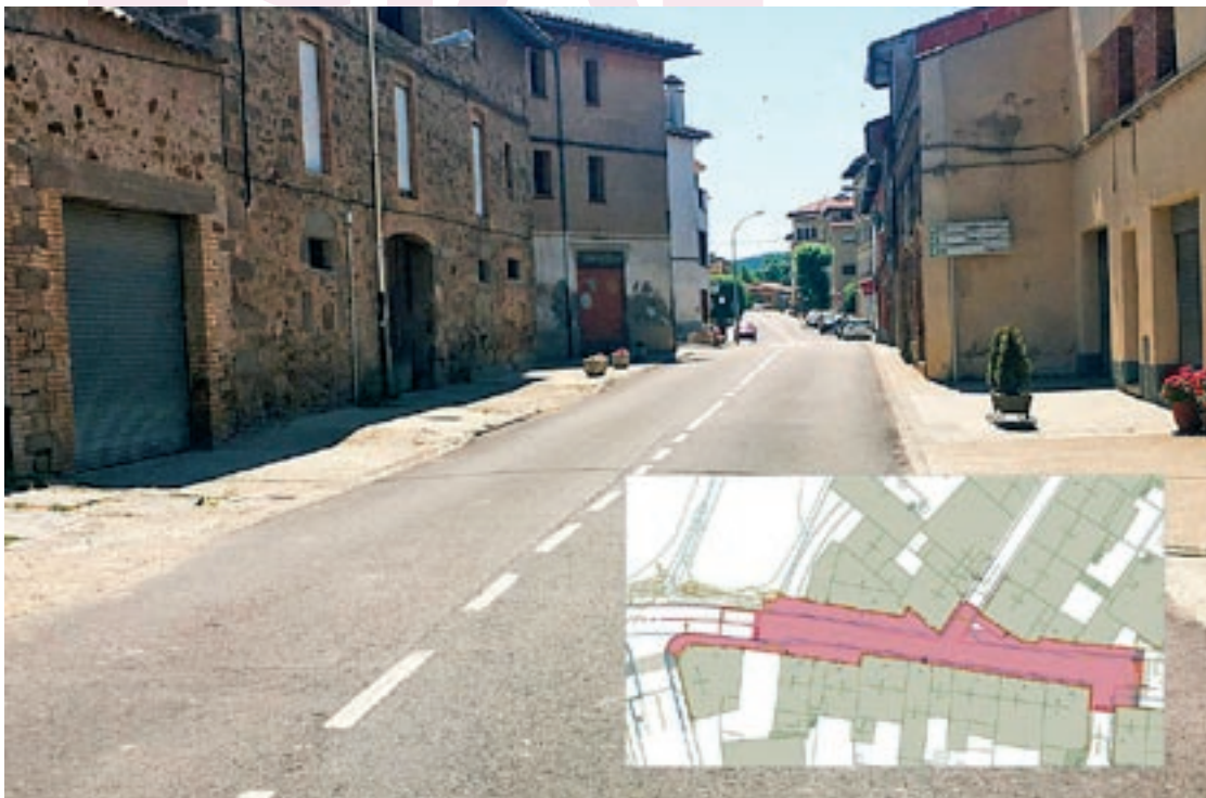
Una imatge de l'estat actual d'aquest tram de carretera; en el requadre, el plànol de la intervenció
