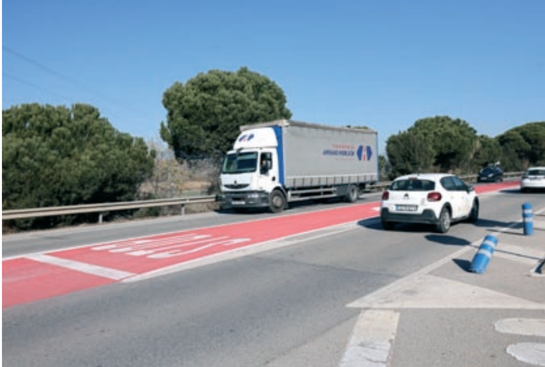
El carril central de la BV-5151 a l'accés sud de Santa Agnès amb el paviment de color vermell en la darrera millora feta
