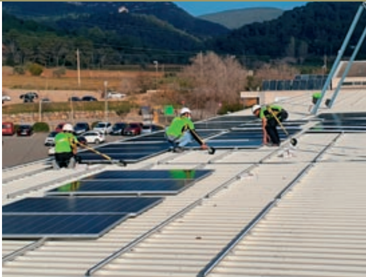
La instal·lació de les plaques al camp de futbol de Caldes
