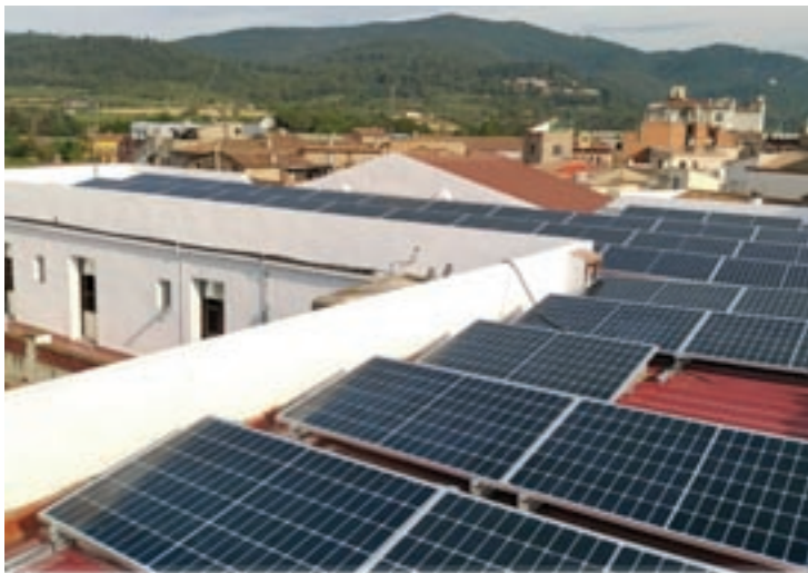
Les plaques de Can Forn d'Electra Caldense
