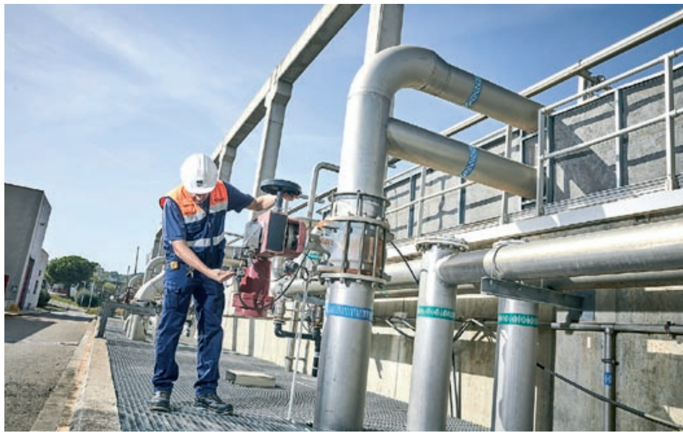
Sistema de filtració per membranes a l'ERA de Sabadell Riu Sec
