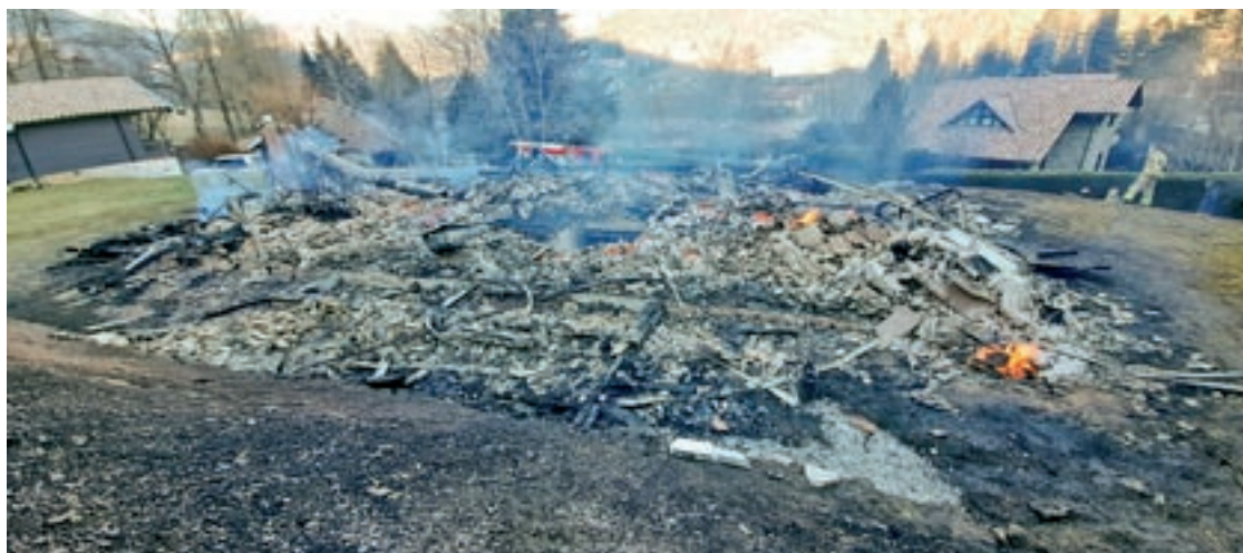
Restes dels habitatges, completament reduïts a cendres a causa del foc
