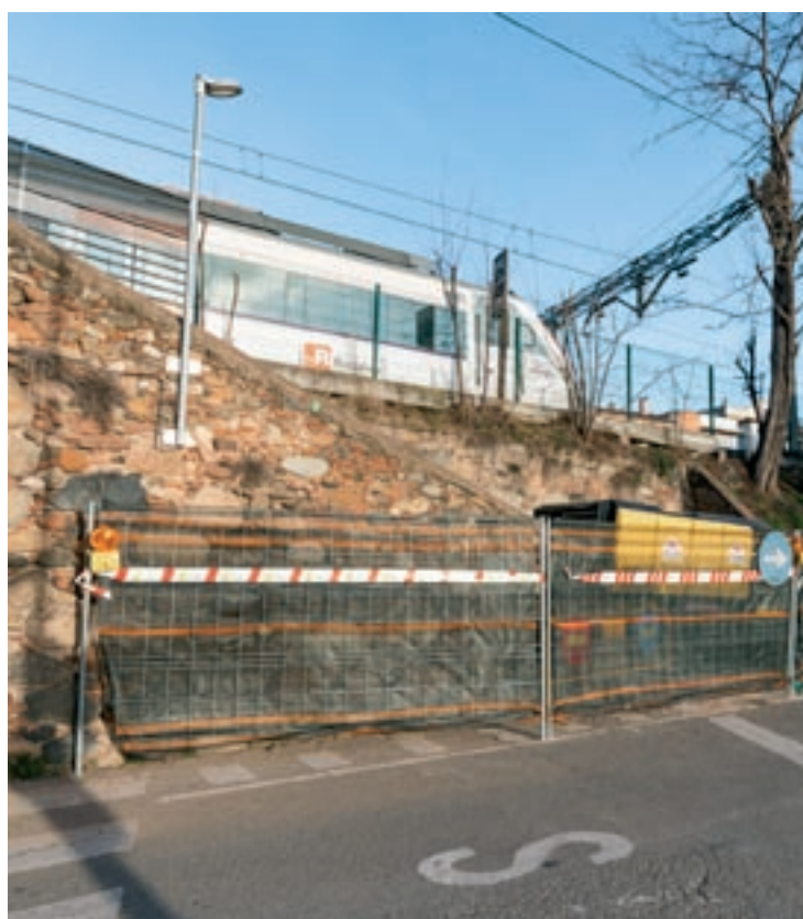
El punt on s'ha de construir el nou pas inferior per a vianants
