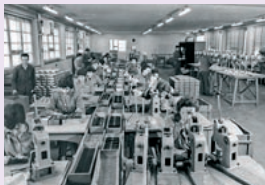
Una imatge exterior de la fàbrica de 1956, ja a la nova nau del carrer Indústria; a baix, operaris treballant-hi
