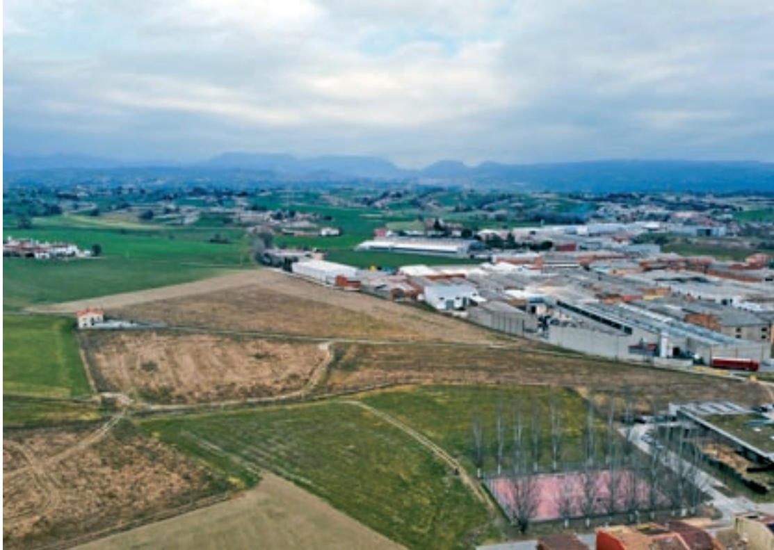
Vista aèria de la superfície que ocuparà el nou polígon de Manlleu, que donarà continuïtat al de la Coromina
