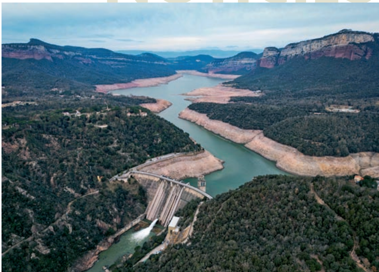
Vista general de l'estat del pantà de Sau i la sortida d'aigua per la presa cap a Susqueda, aquest dijous al matí
