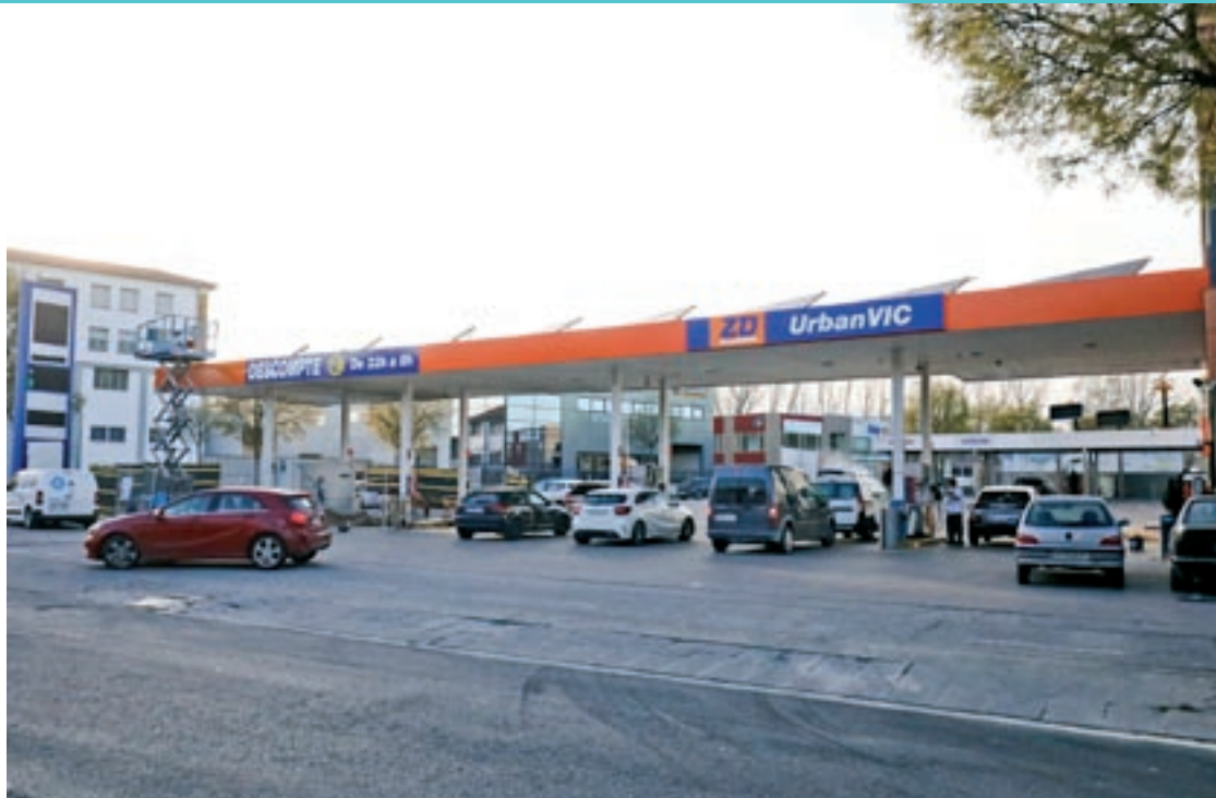
Aspecte de la gasolinera del polígon del Sot dels Pradals que s'ha integrat a l'estructura de Feixas Aulet
