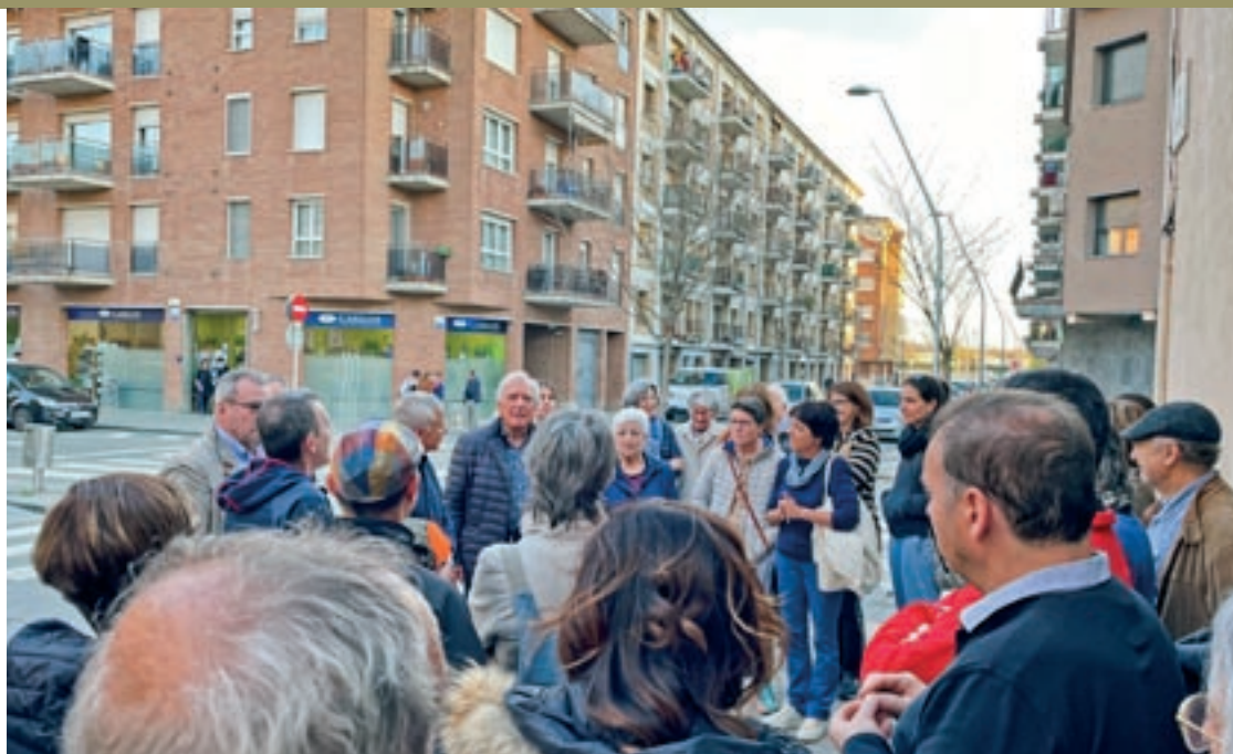
Divendres passat es va fer una visita guiada pel barri. Al fons, el primer dels tres blocs que es van construir
