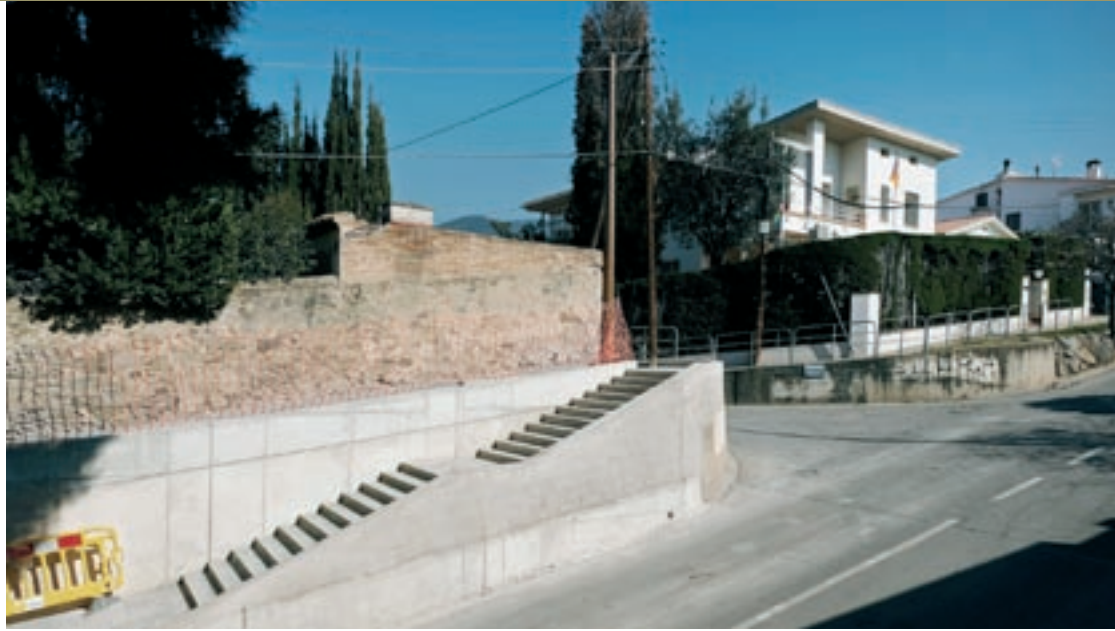
L'escala s'ha construït amb materials que facilitin el seu enderroc quan l'Ajuntament actuï a l'altre costat de la vorera
