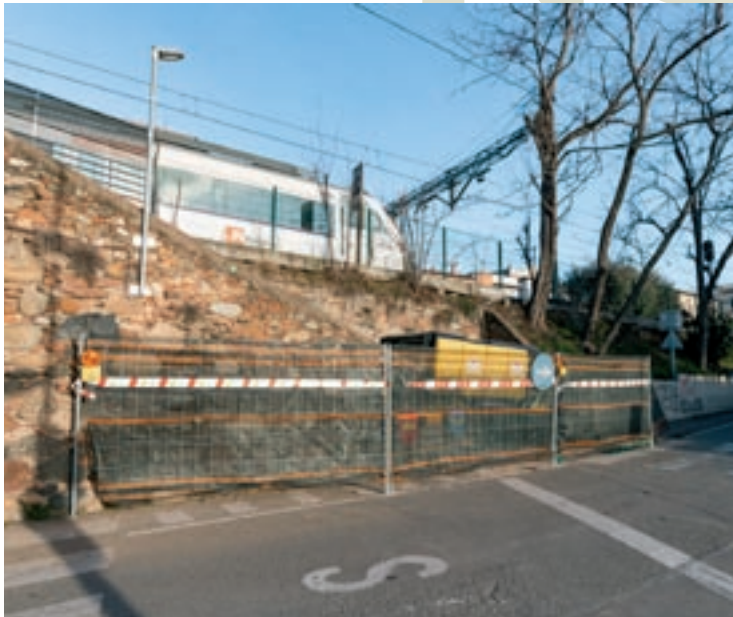
El punt on s'ha de construir el nou pas inferior per a vianants
