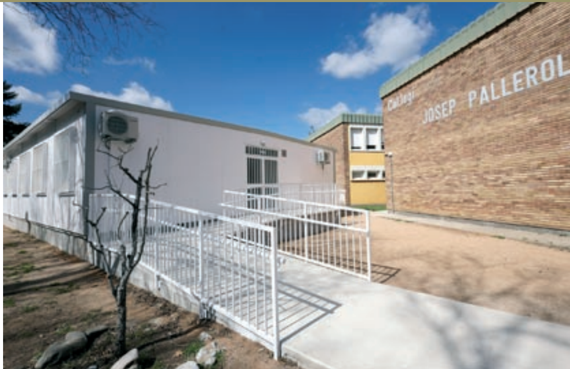
El nou mòdul del Pallerola està instal·lat des del mes de novembre, però segueix sense acollir classes
