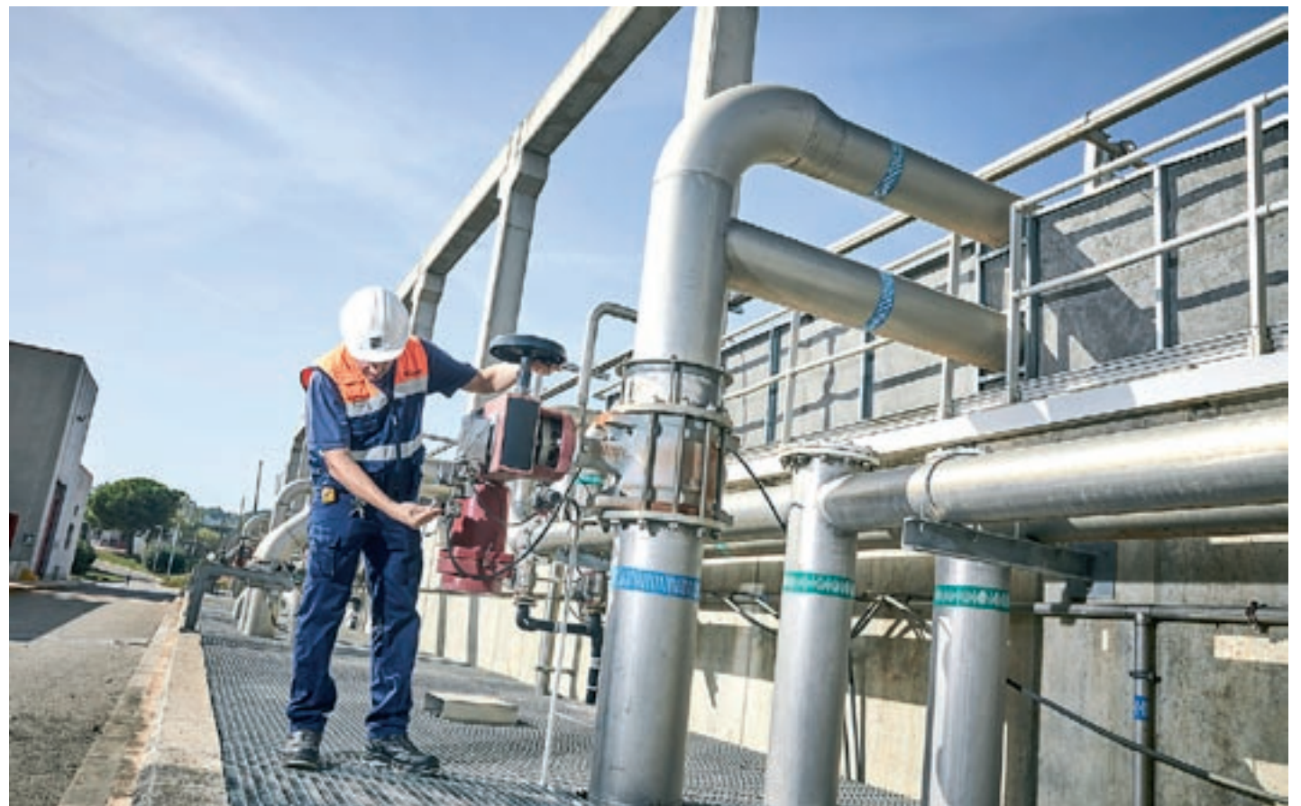
Sistema de filtració per membranes a l'ERA de Sabadell Riu Sec
