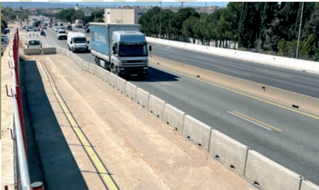
L'accés a Idilia Foods amb el tercer carril guanyat a la calçada en sentit nord de la C-17 des del nou vial paral·lel
