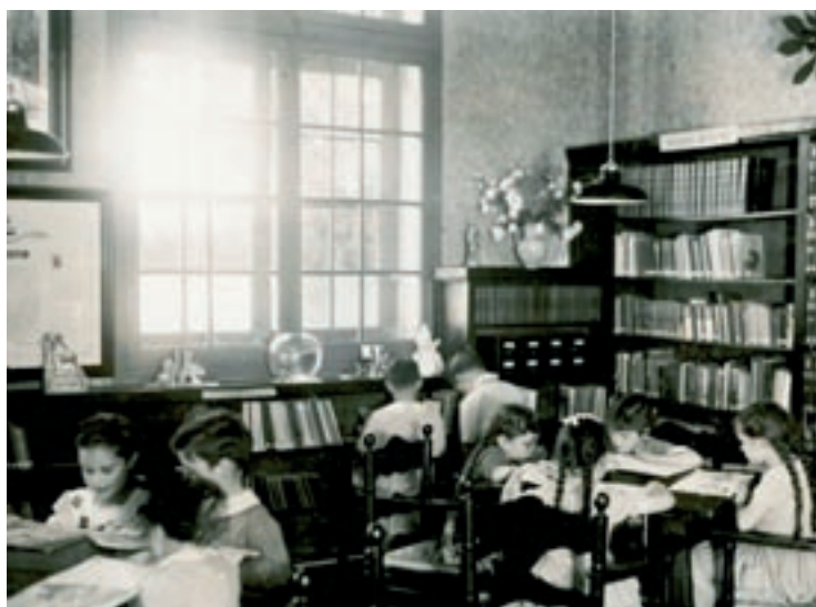
L'interior de la Mongia, el primer edifici que va acollir la biblioteca
