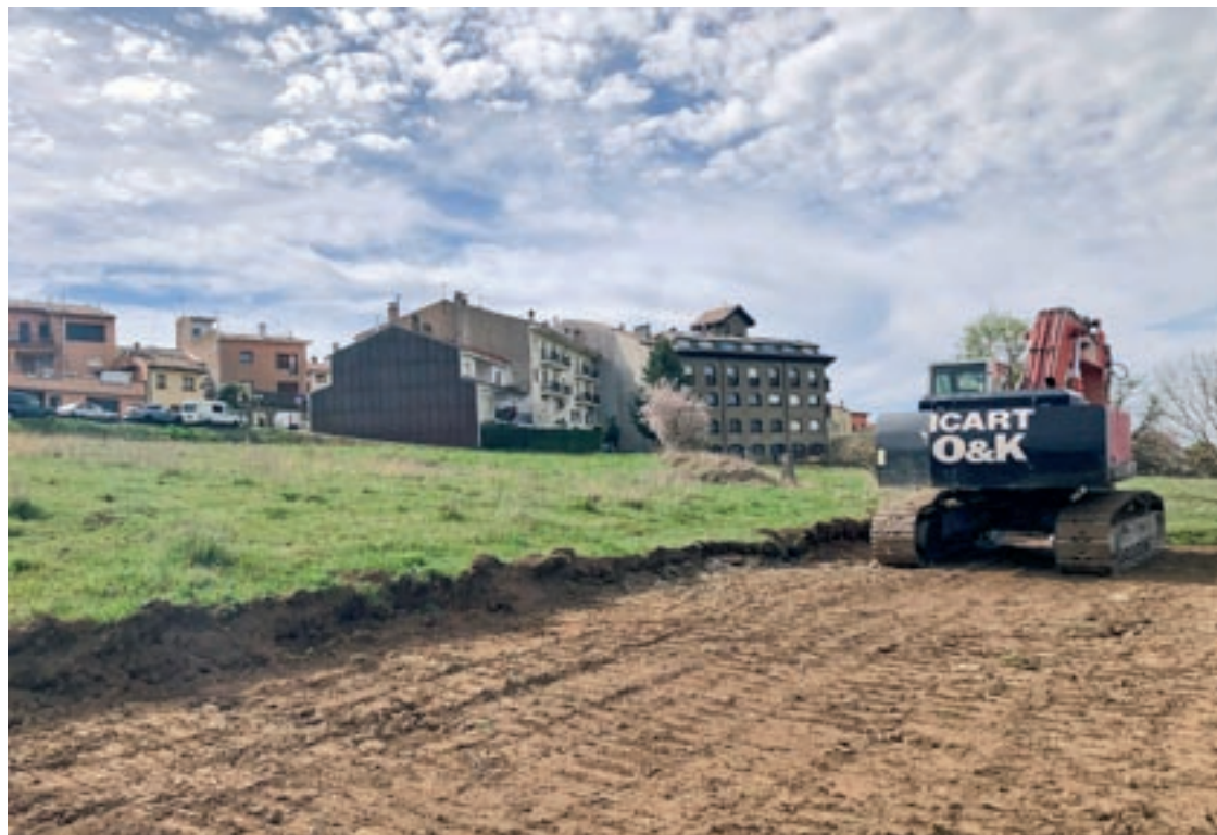
Les obres volen donar cobertura de sanejament a un 70% de la població del municipi
