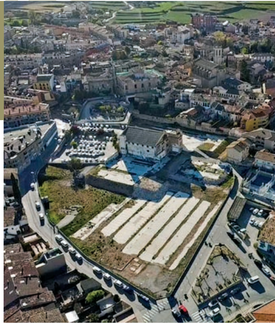
Vista aèria de Centelles, amb els 16.000 metres quadrats del Vapor a la part inferior de la foto.
