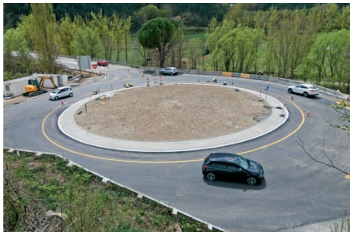
Estat actual dels treballs a la rotonda
