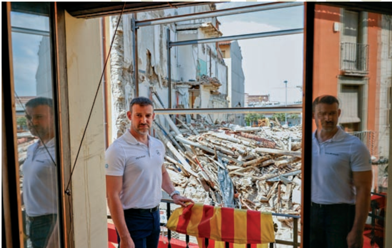
Carles Sobrino al balcó d'un veí des d'on es veuen les dues cases esfondrades al carrer Nou de Vic
