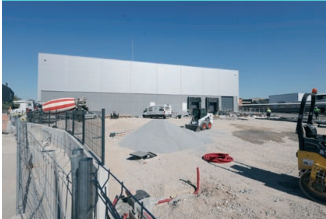
Els treballs de construcció de les noves instal·lacions, de 6.500 metres quadrats, estan avançats
