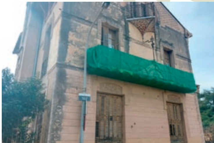
La Torre Iris, al carrer Figueral, conserva impactes de metralla
