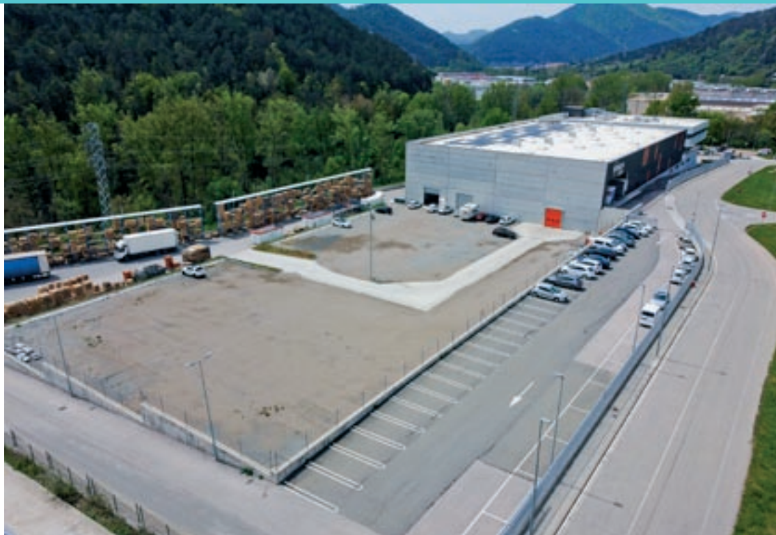
Les instal·lacions de Sodeca a Ripoll. En primer terme, l'espai on s'aixecarà el nou magatzem logístic
