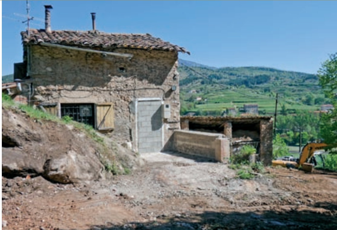
Vista de la Caseta d'en Jordana de Ripoll
