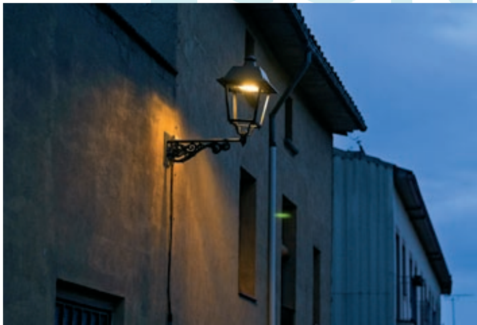
La mateixa lluminària, instal·lada al carrer de Berga d'Olost, emet més o menys llum en funció de si detecta moviment al carrer
