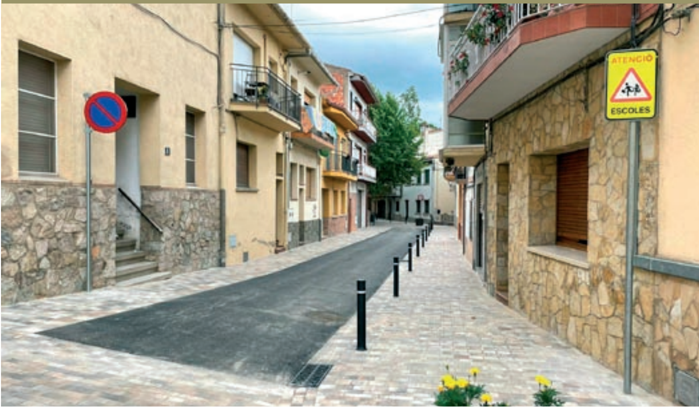
Una de les obres d'aquest mandat ha estat la pacificació del carrer Bisbe Ponç, al centre de Gualba
