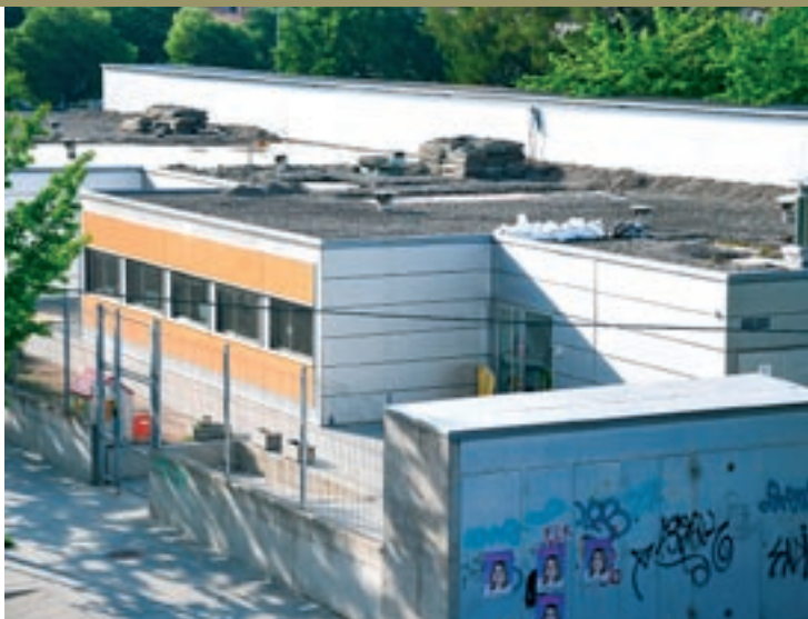
La coberta d'infantil en una imatge de dimecres després dels treballs iniciats
