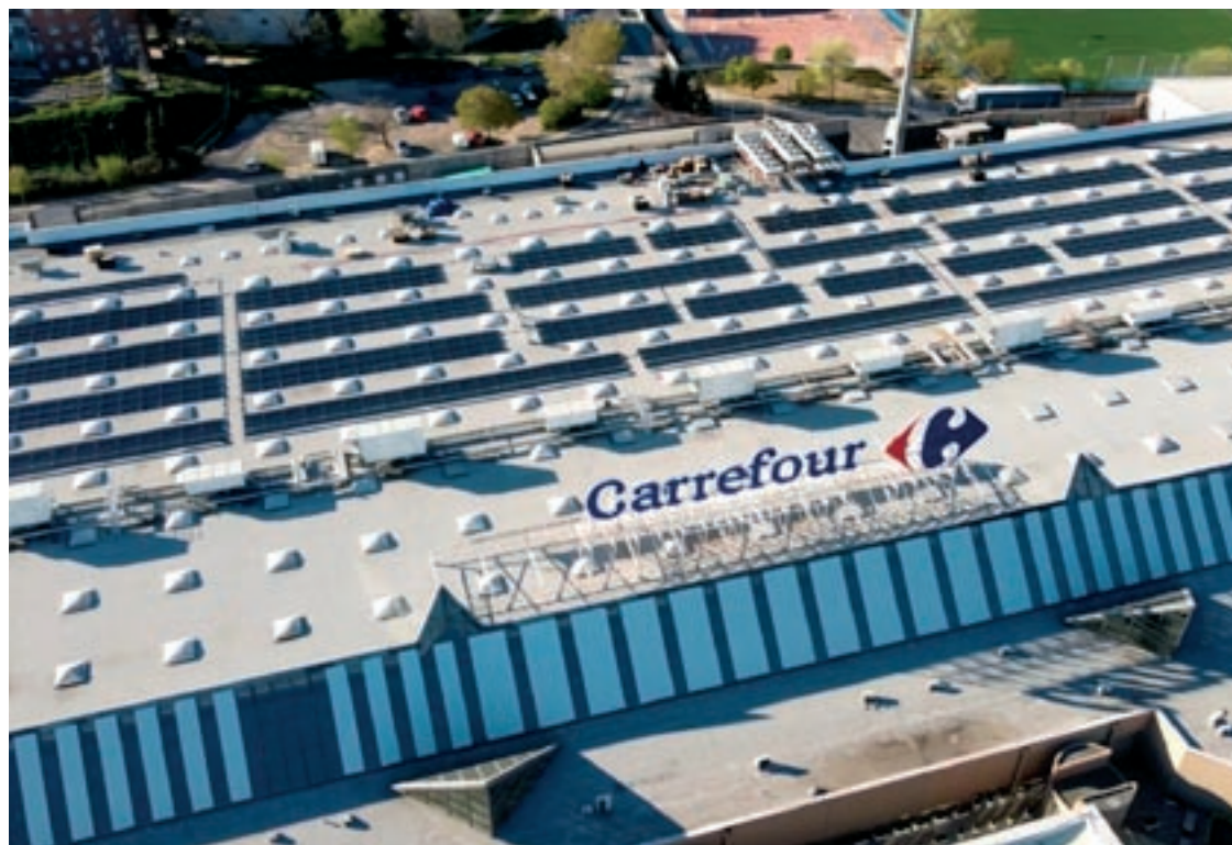
Una de les teulades d'establiments Carrefour que ja ha instal·lat plaques solars
