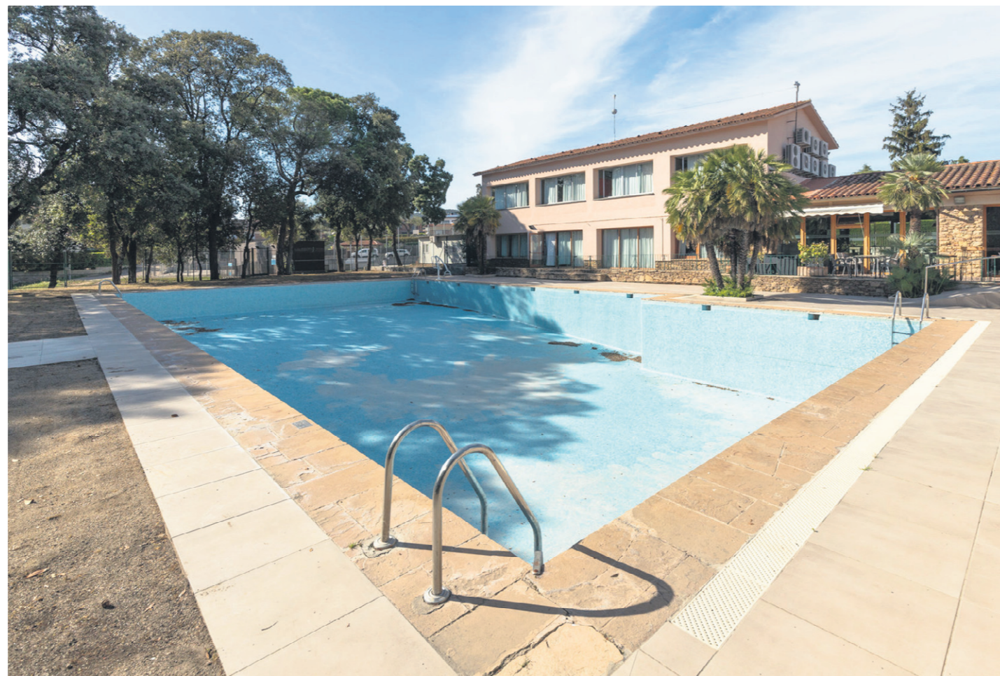
A dalt, la piscina que Vilanova que s'acabava d'omplir dijous amb aigua de cisternes. A sota, la piscina de Can Camp, a l'Ametlla, buida per les esquerdes
