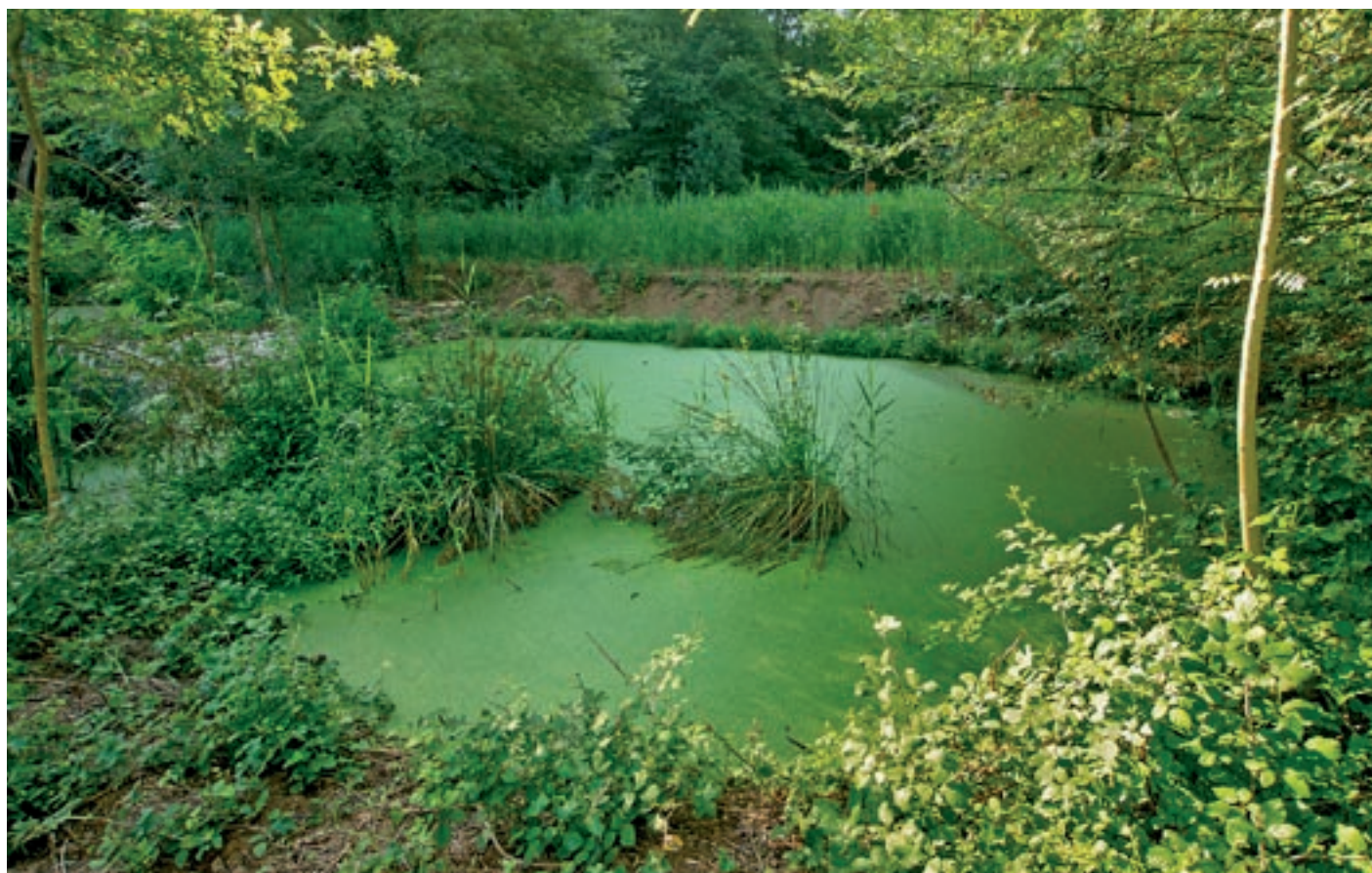
Restauració dels aiguamolls de depuració de Begudà, a Sant Joan les Fonts
