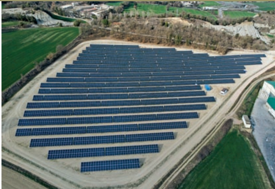
El parc solar fotovoltaic que alimenta la fàbrica de pinso d'Esporc, a Tona
