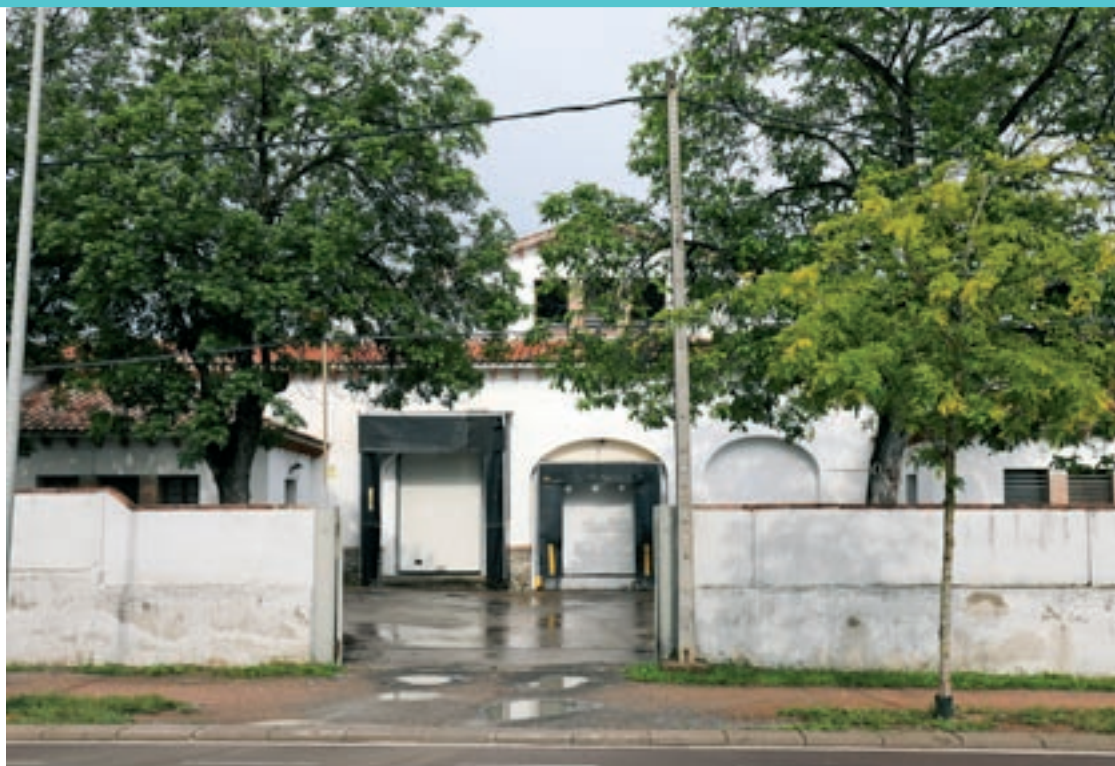
L'escorxador de Manlleu està ubicat al carrer Torrent de la Borina, a tocar del passeig del Ter
