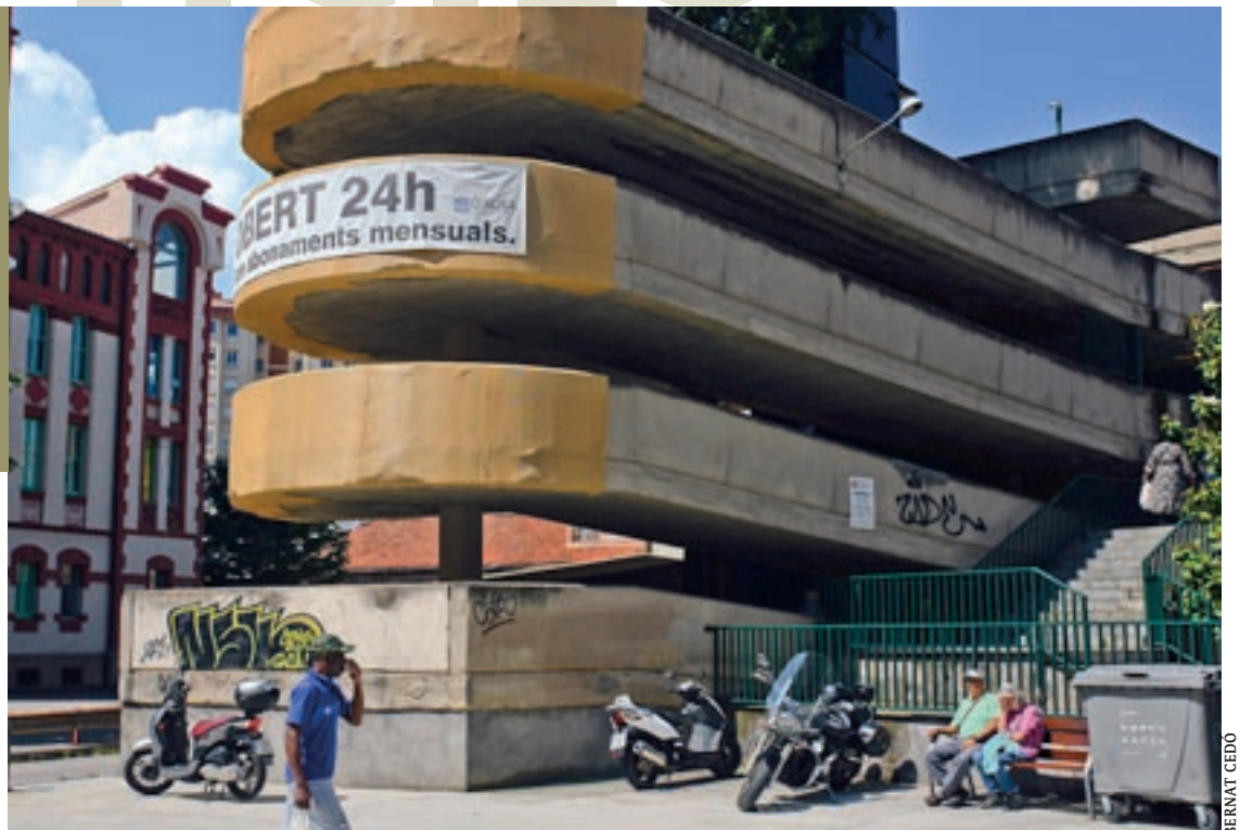
Vista d'una de les façanes del Mercat Municipal de Vic
