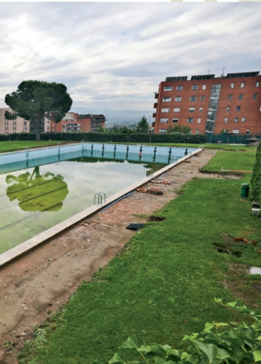
la maquinària i s'ha retirat l'empedrat de l'entorn
