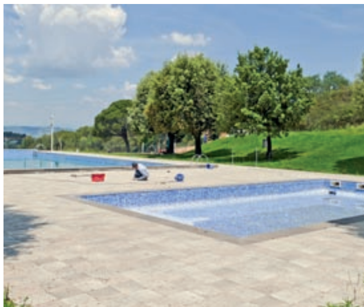
Les obres de la nova entrada a la piscina de Taradell
