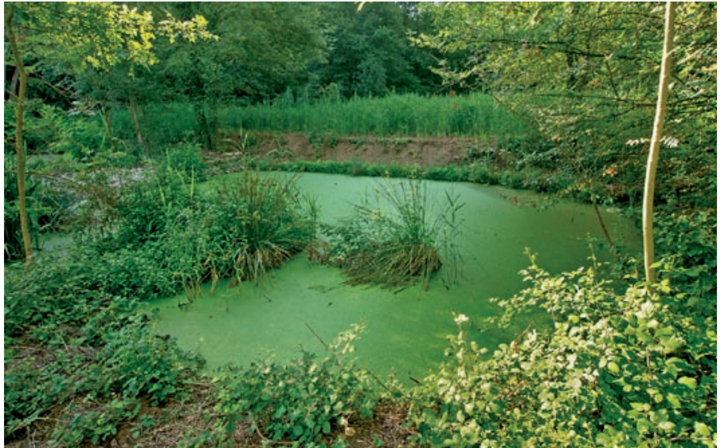
Restauració dels aiguamolls de depuració de Begudà, a Sant Joan les Fonts
