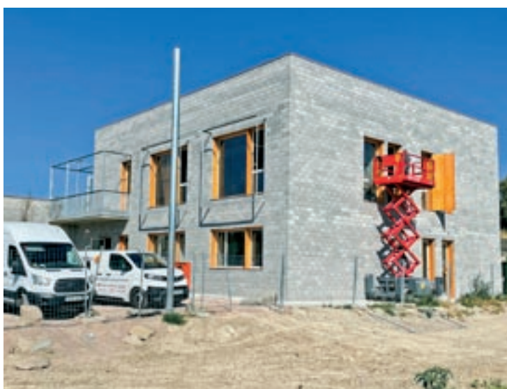
L'estat de les obres de la unitat de convivència, aquest dijous
