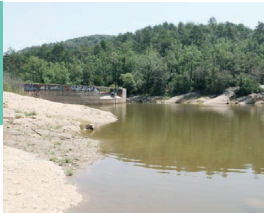
L'embassament de Granera. L'alcalde assegura que l'aigua és massa tèrbola per utilitzar-la per al consum
