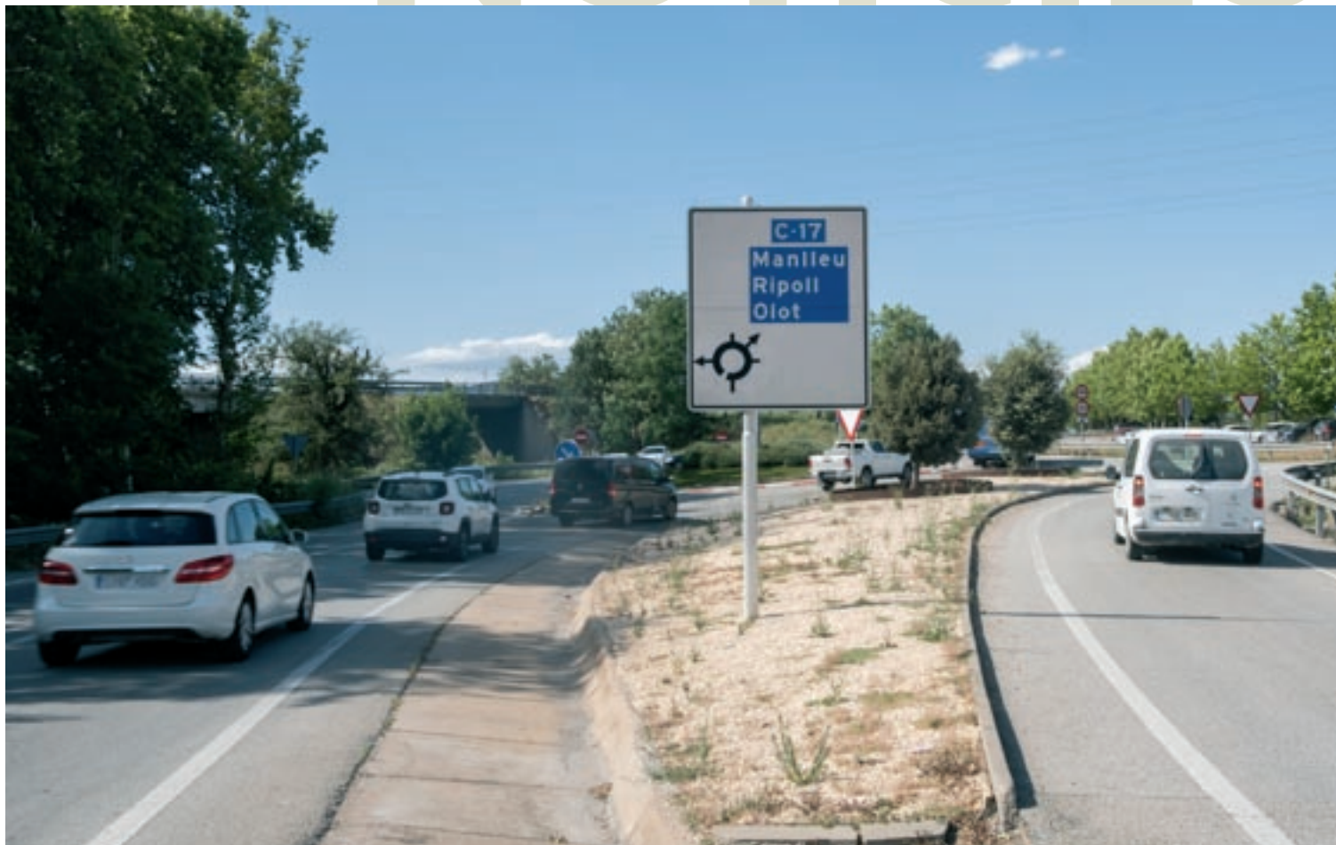
Un vial anirà paral·lel al trànsit entre les dues rotondes per connectar l'Eix i la C-17 i evitar així el col·lapse en aquest tram d'enllaç
