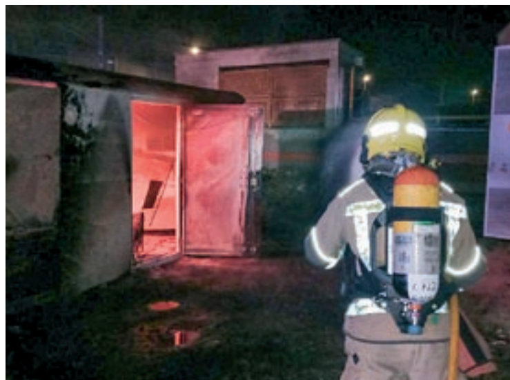
Imatge de les flames al transformador de la fàbrica d'embotits
