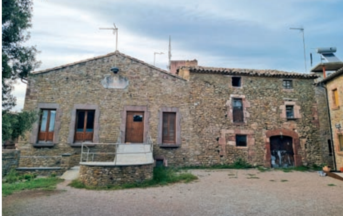
Façana de Can Manyosa, que serà enderrocada. L'edifici, que acull pisos socials, ja ha patit diferents modificacions
