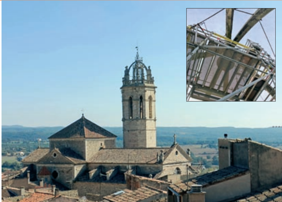
Aspecte actual de l'església de Moià. En la fotografia de detall, la bastida que hi ha muntada al campanar
