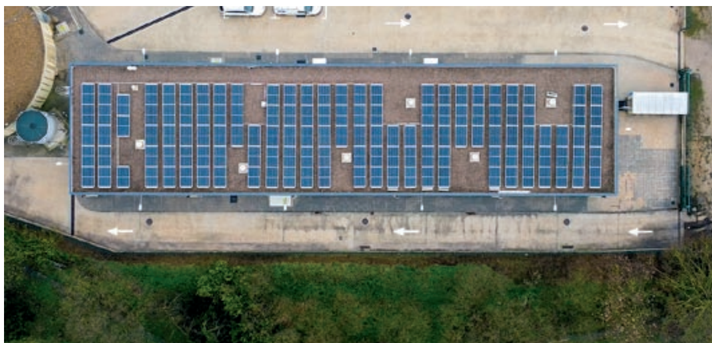
Instal·lació fotovoltaica a la planta de Sant Celoni
