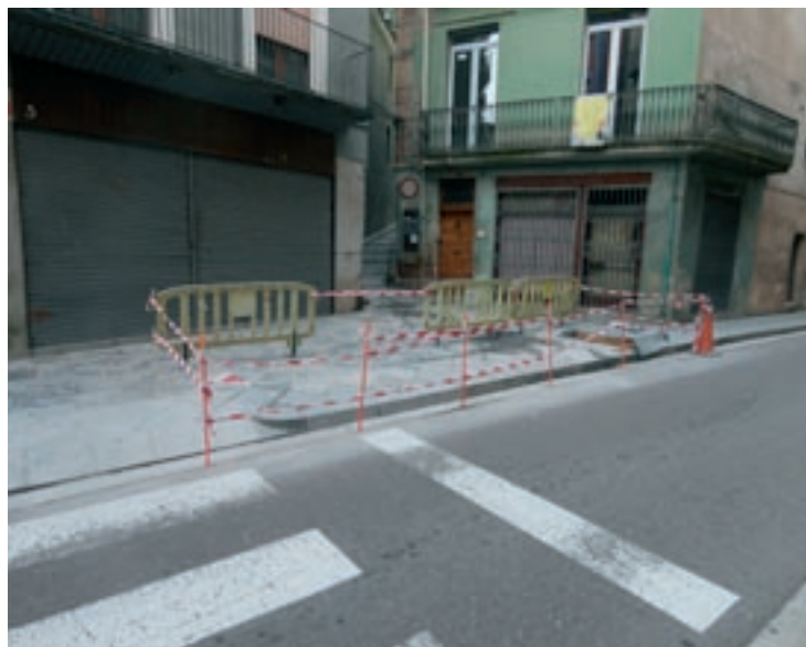
Estat de les obres al carrer del Prat de Ripoll
