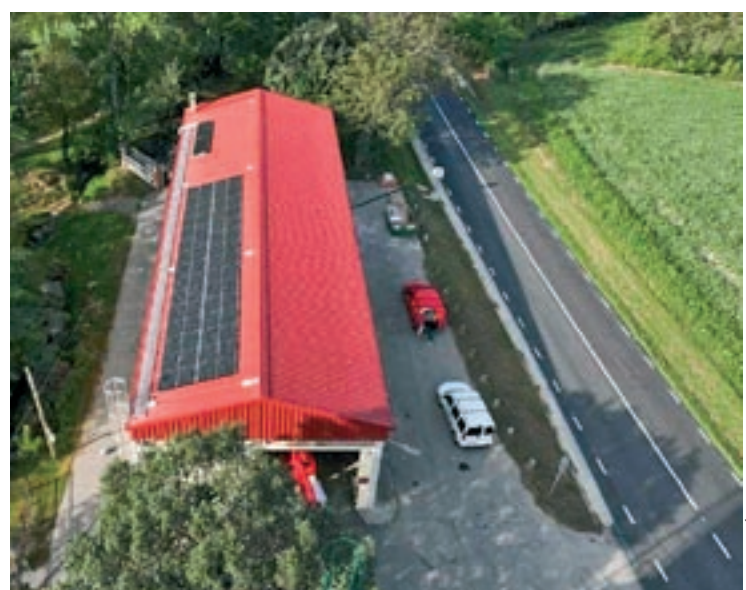
La teulada de l'edifici, ja amb les plaques fotovoltaïques
