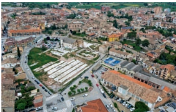
La zona del Vapor, al centre de Centelles, a vista d'ocell
