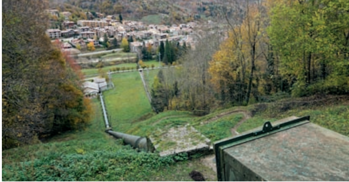
Vista de la canalització que va de la bassa a l'entrada de la central hidroelèctrica. Al fons, Llanars
