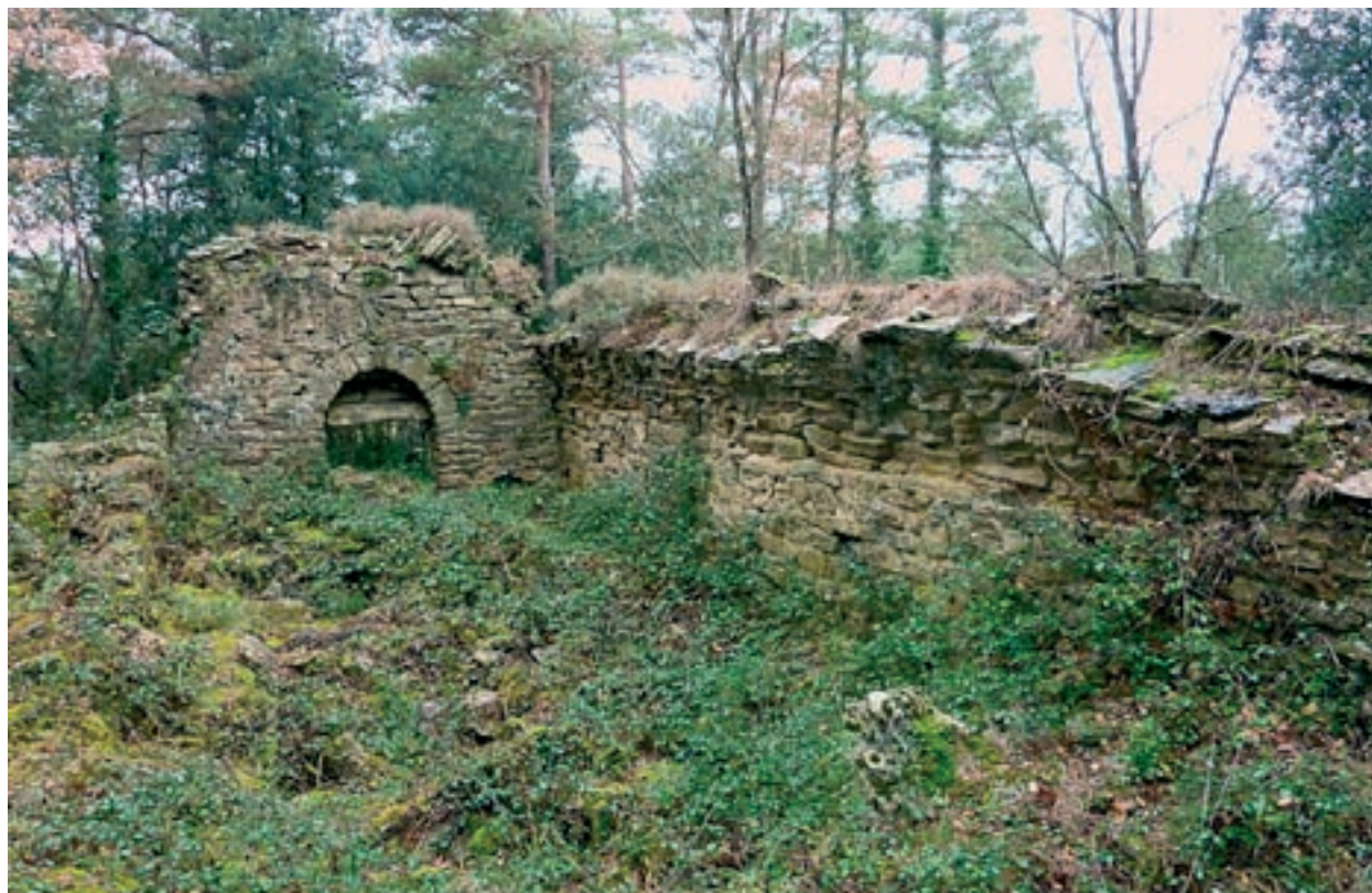
Imatge actual de l'estat de la capella
