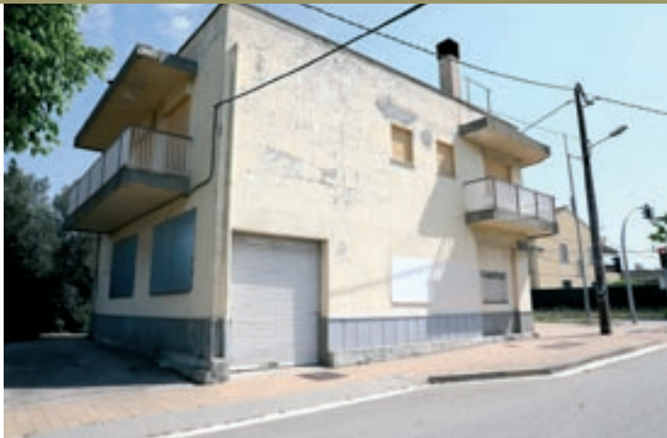
La casa de Palou que es transformarà en alberg de transeünts
