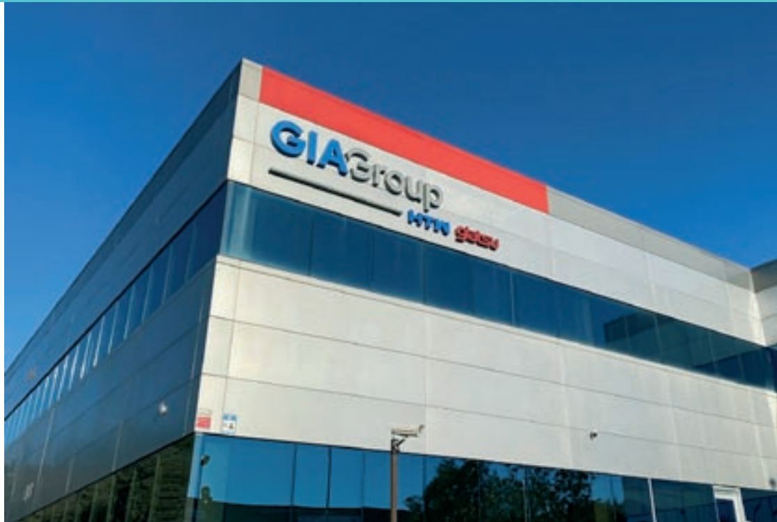
Aspecte de les instal·lacions de Granollers, on el grup es va traslladar a principi de 2022
