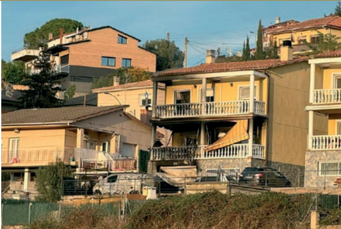
Els danys a l'habitatge, sobretot al soterrani on hi ha el garatge, són molt visibles per la part del darrere
