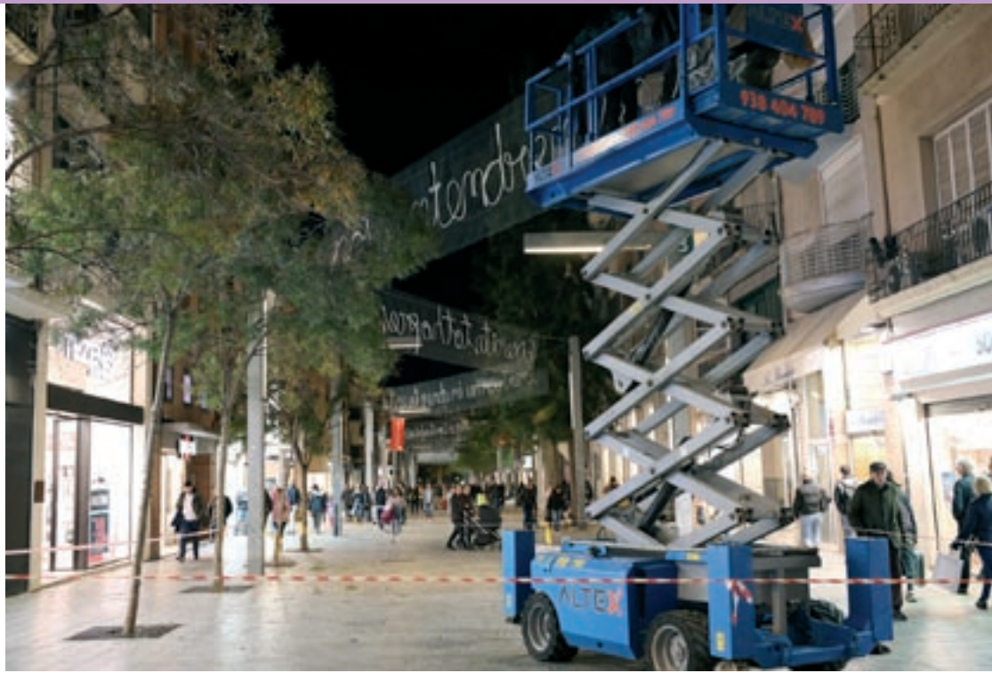
Els treballs d'instal·lació dels missatges al carrer Anselm Clavé de Granollers, aquesta setmana
