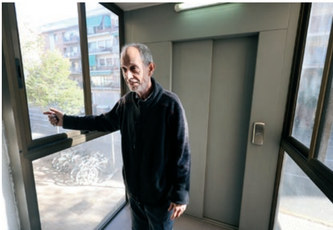
Pere Clemente mostra els tancaments de la façana on hi ha l'ascensor que es podrien millorar amb la reforma
