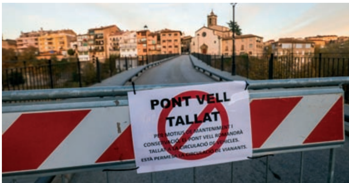
El pont Vell està tallat al trànsit rodat des de mig novembre
