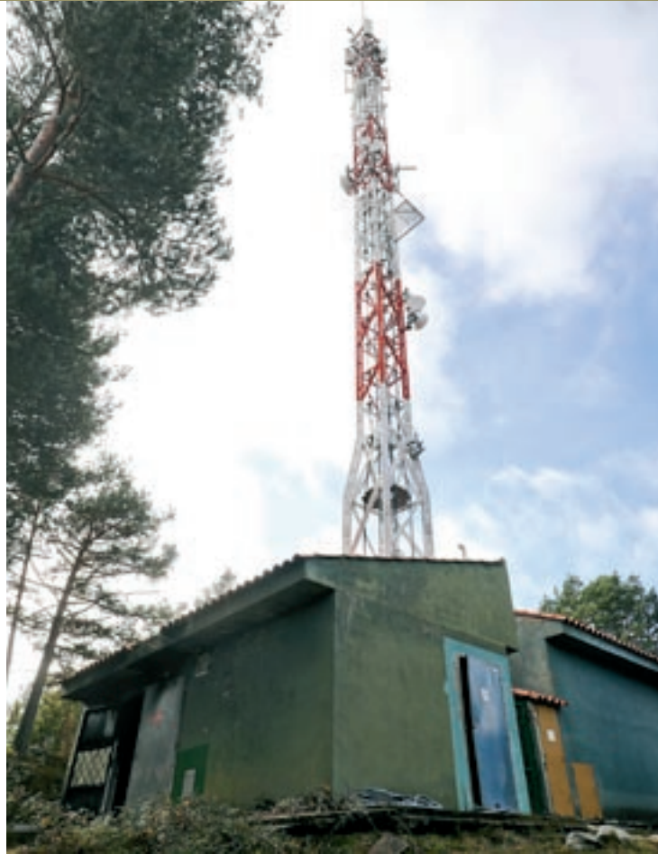
El repetidor de Puigdon, ubicat a Alpens
