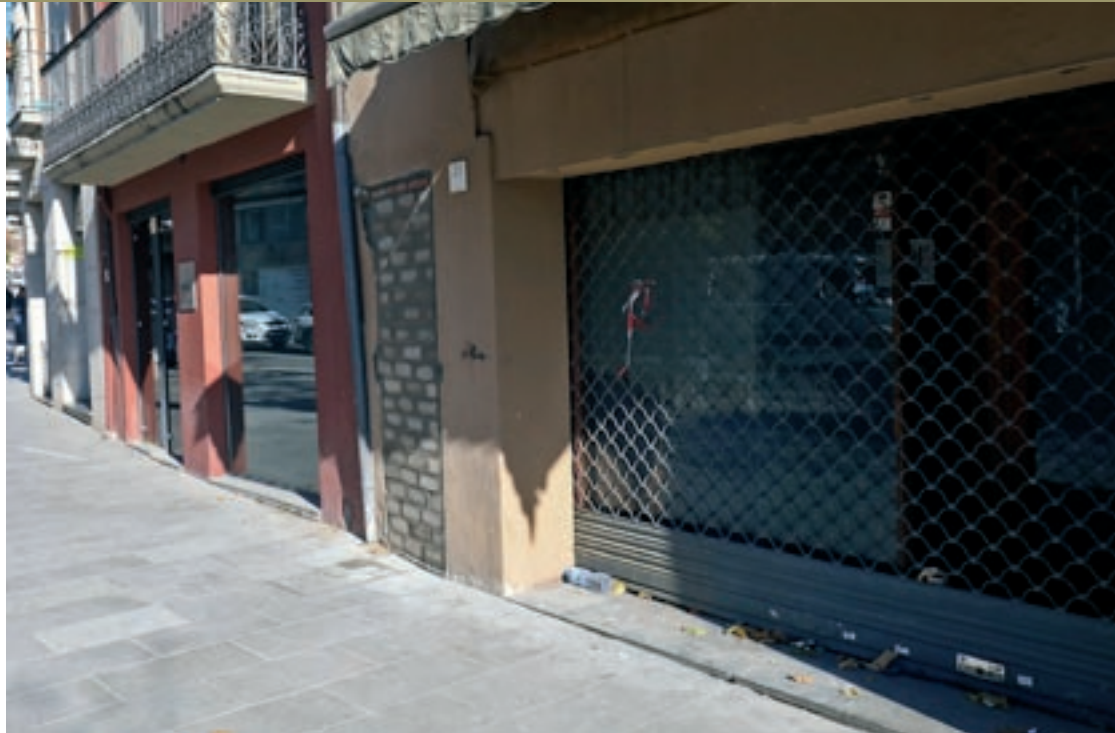
La façana de l'edifici, amb l'entrada tapiada amb blocs de formigó
