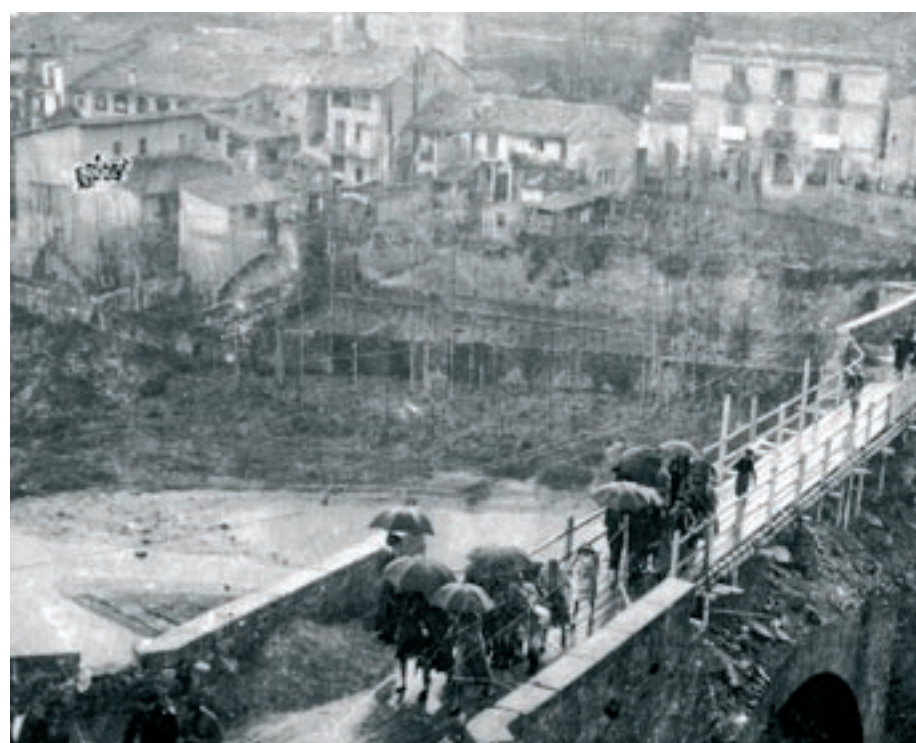
Les actuacions de consolidació del pont Vell de Roda de Ter, que van acabar dilluns, a la part
