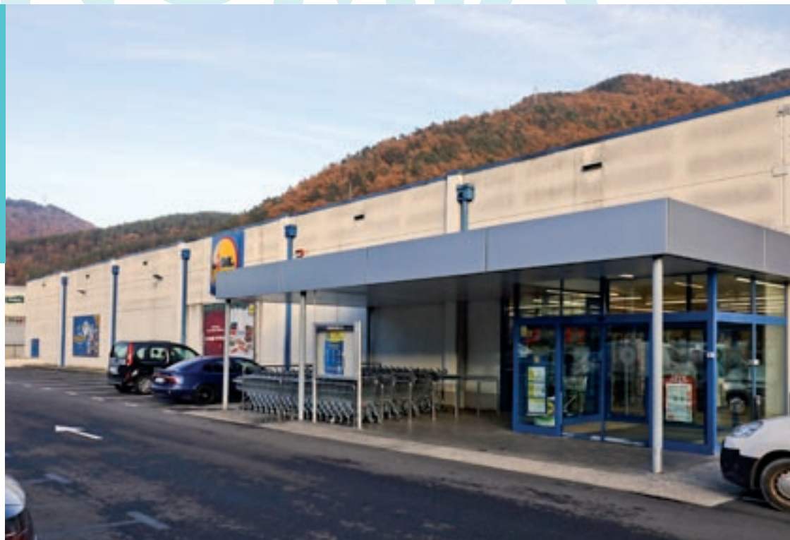
L'actual supermercat Lidl de Ripoll anirà a terra un cop tinguin construït i en funcionament el nou
