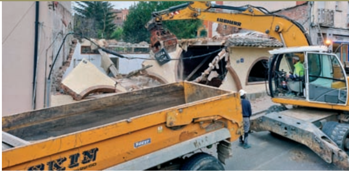
Demolició de l'antic Celler d'en Toni, que va conservar el cartell fins al moment de l'enderroc
